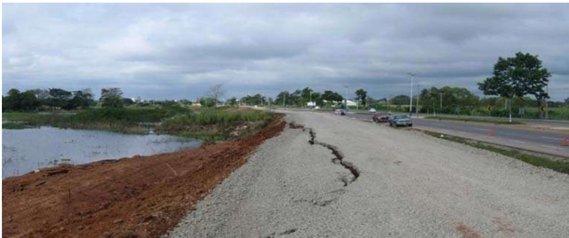
Figura 12. Falla por cortante con hundimiento y desplazamiento, fuente: (PHIT, 2008).
