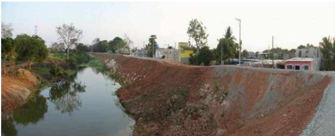
Figura 11. Hundimiento en el bordo, debido al peso transmitido, fuente: (PHIT, 2009).
