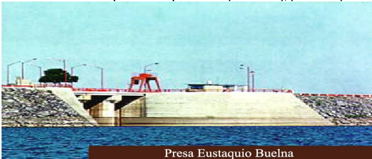
Fotografía 18. Panorámica de la presa Eustaquio Buelna (Guamúchil), (1969-1972)
