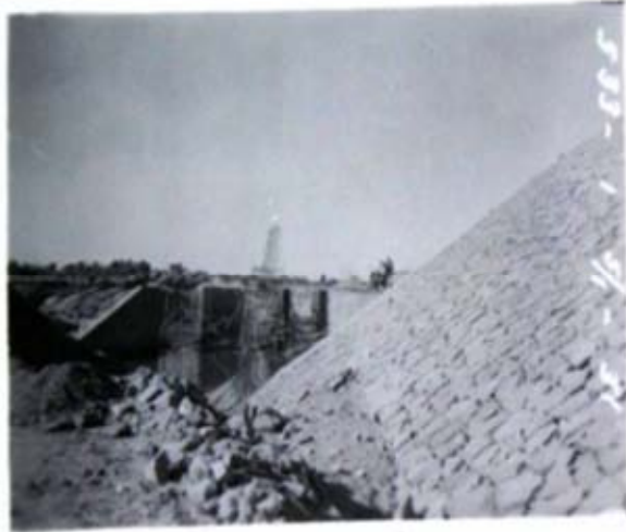
Fotografía 38. Desarenador presa derivadora Cahuinahua, (1951)
