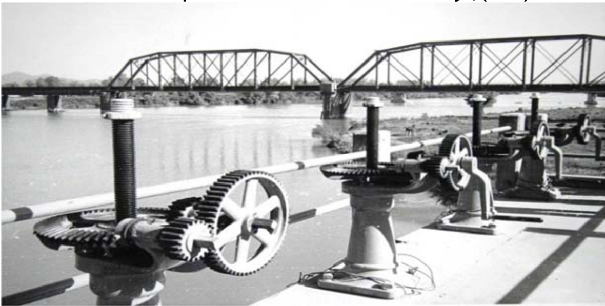
Fotografía 42. Compuertas del DR 010 Culiacán-Humaya, (1964)
