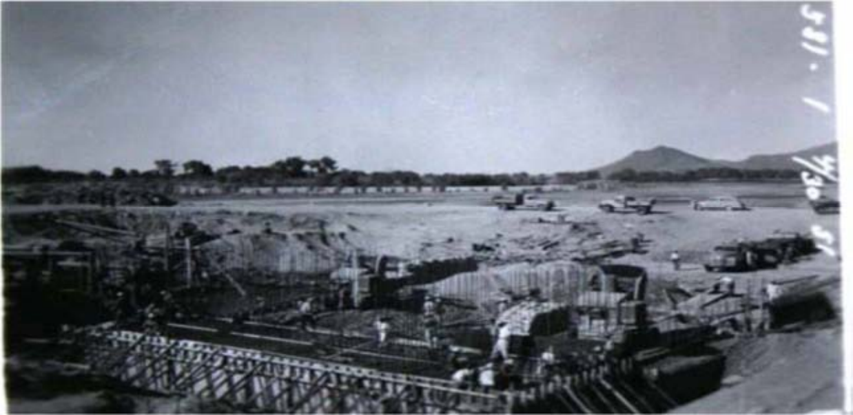
Fotografía 37. Presa derivadora SICAE, en construcción, (1951)
