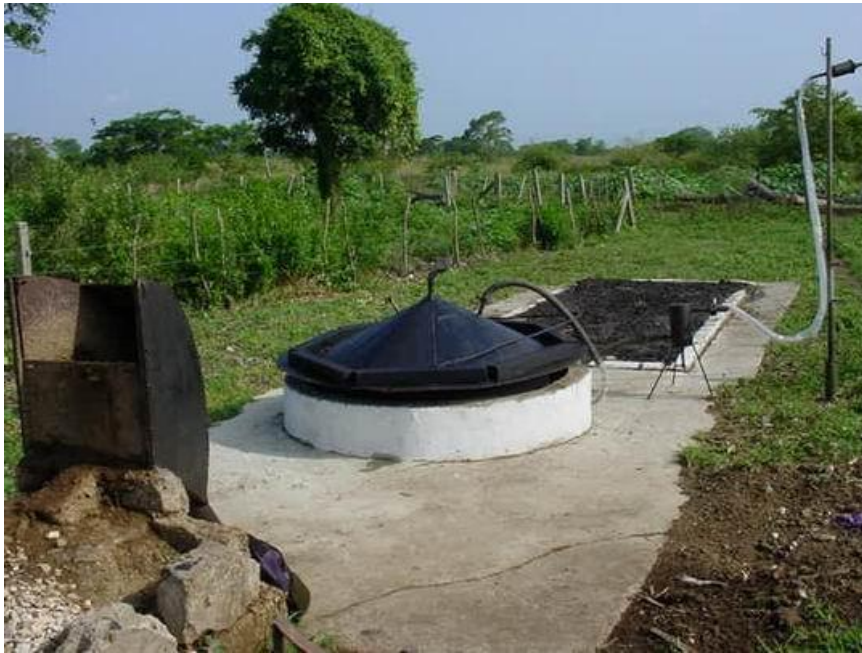
Fig. 5.7 Fuente: cienciasseptimodosmiravalle.com. Biodigestor Chino.
