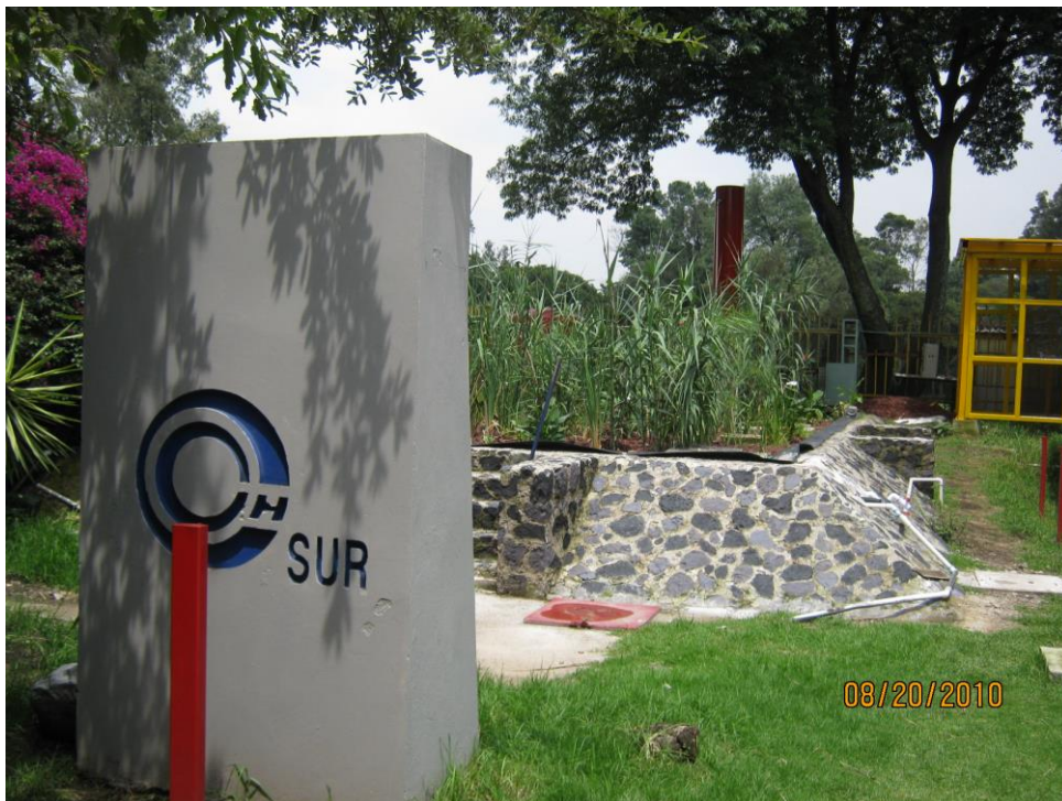
Fig. 7b. Humedal artificial de flujo horizontal en el CCH Sur (Sánchez-Tovar, 2010)
