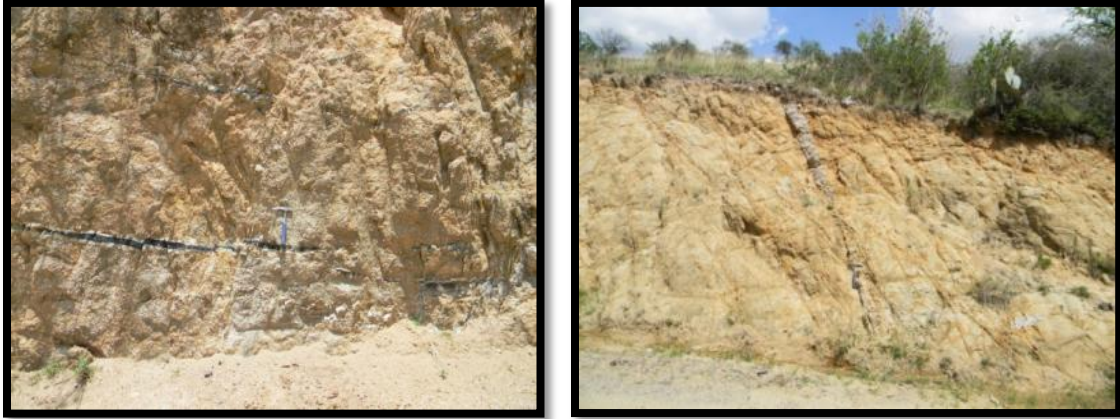
Figura 59. Fallas y fracturas de la última etapa de deformación.
