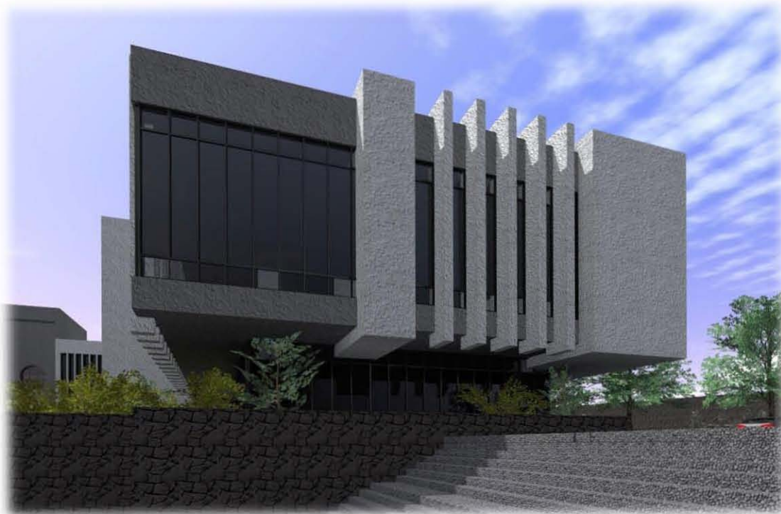
Imagen VII.II.I, Imagen VII.II.II. Edificio Administrativo Fachada "norte".
