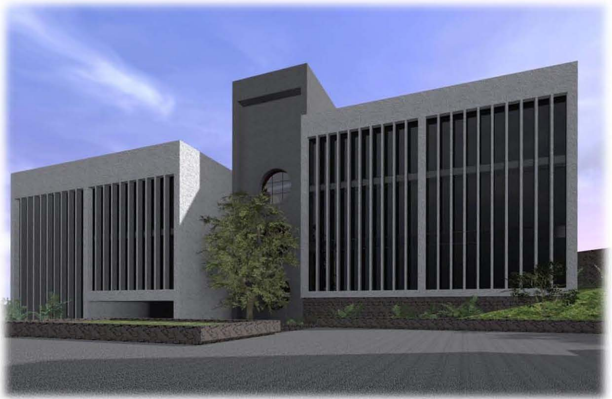
Imagen VII.III.III, Imagen VII.III.IV. Arriba fachada "sur", abajo fachada "norte".
