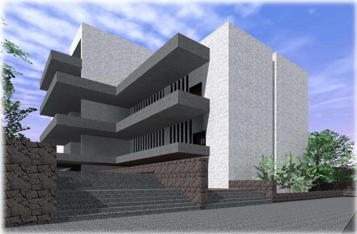
Imagen VII.III.I, Imagen VII.III.II. Arriba fachada “poniente”, abajo fachada “oriente”.
