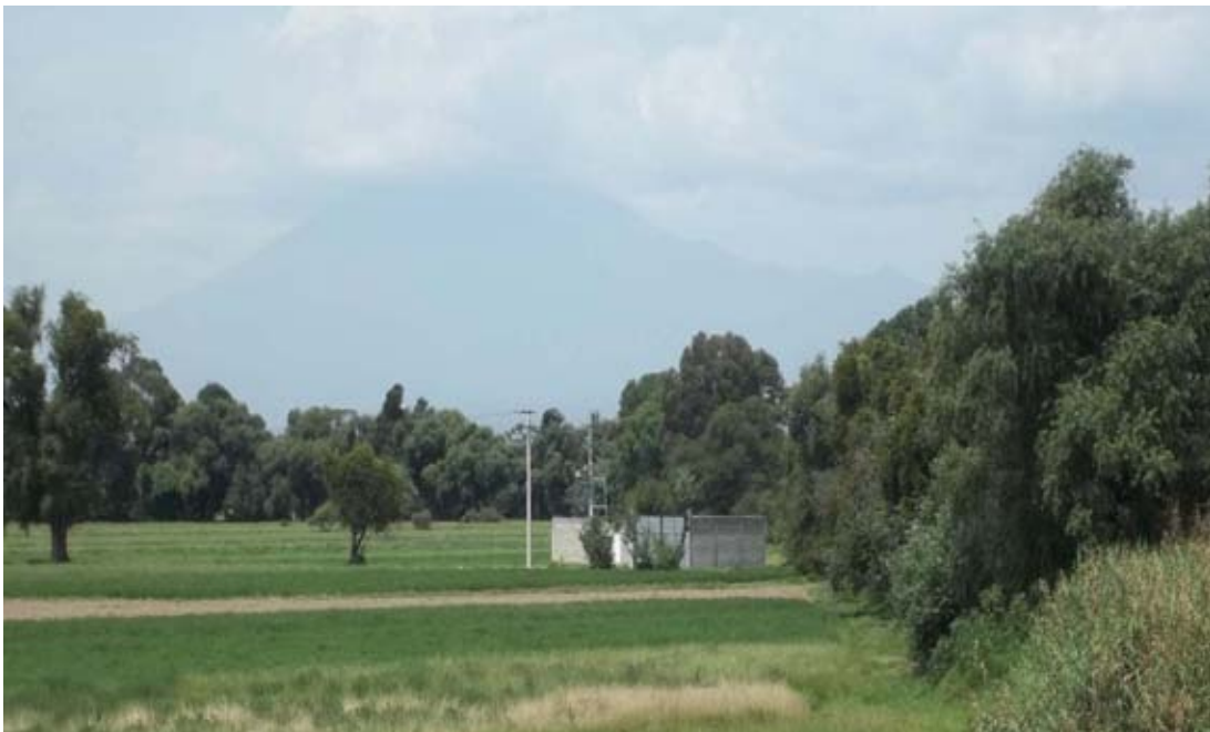
Fuente: Trabajo de campo (2010). Ubicación del sistema de riego de las parcelas ejidal por bombeo de agua de pozo a través de tubería y por motor eléctrico.
