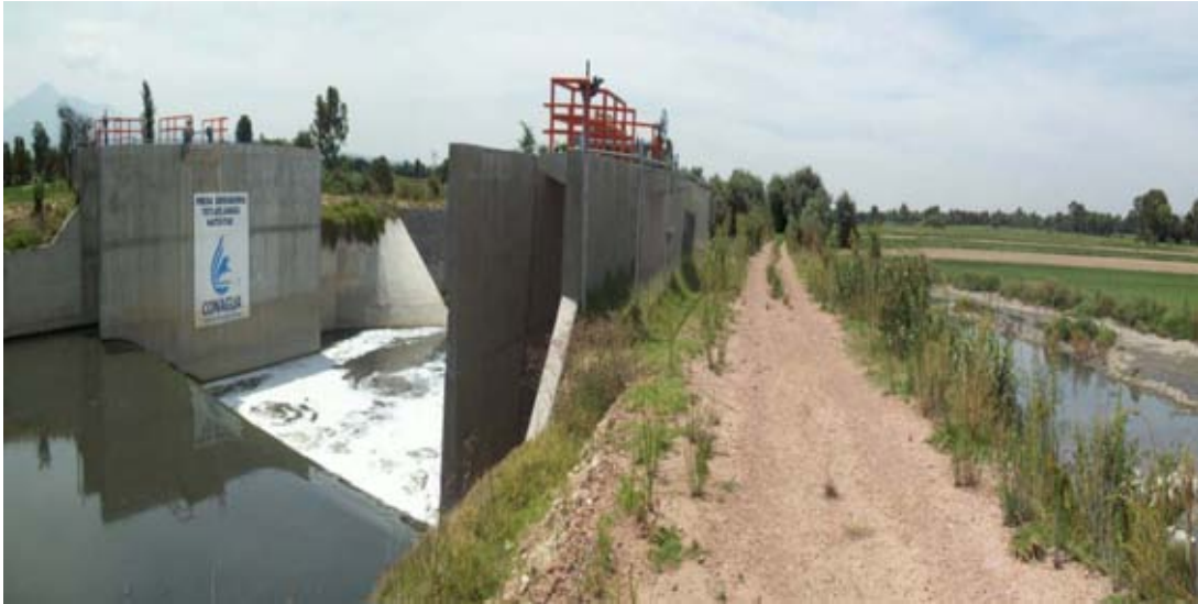
Fuente: trabajo de campo (2014). Río Zahuapan y las contrapuestas por canal para el riego.
