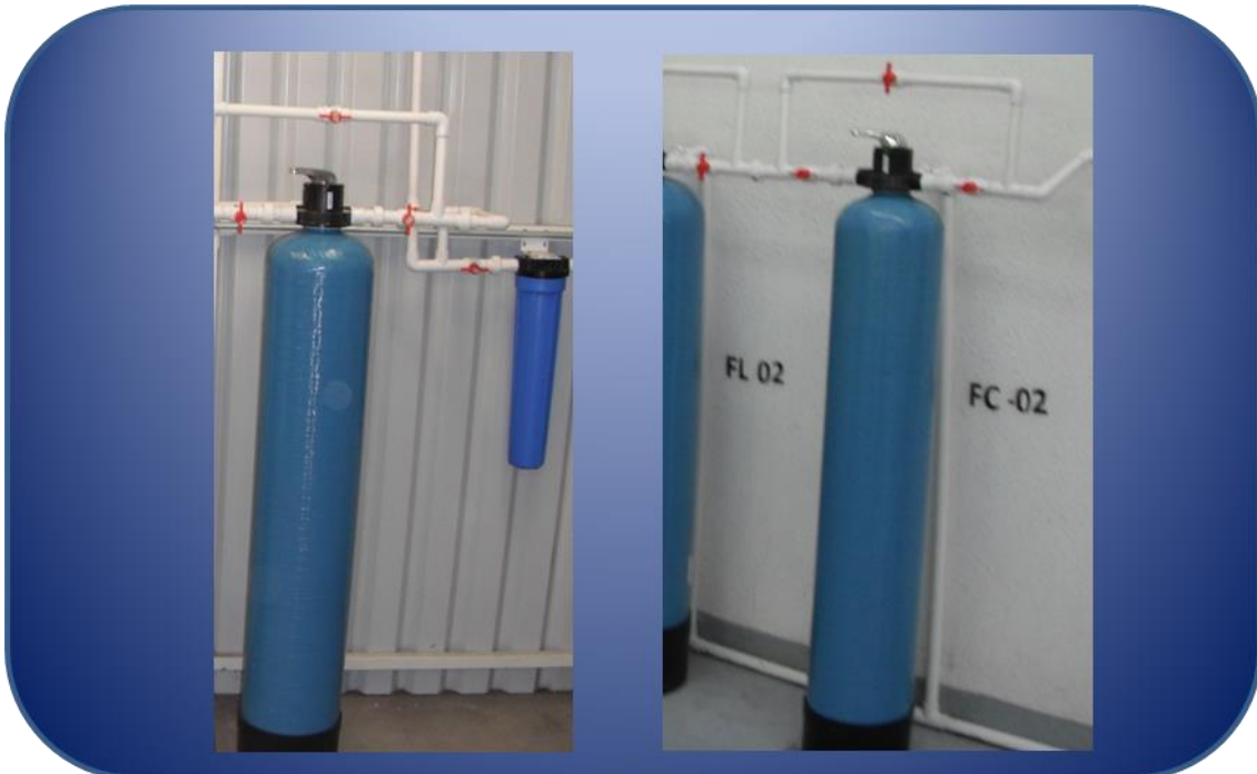
Figura 62. Muestra los filtros de carbón activado FC-01 de ambas plantas purificadoras.
