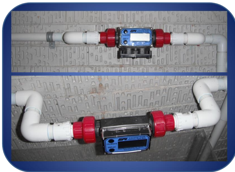
Figura 64. Muestra el medidor/cuantificador de flujo de Campus II.
