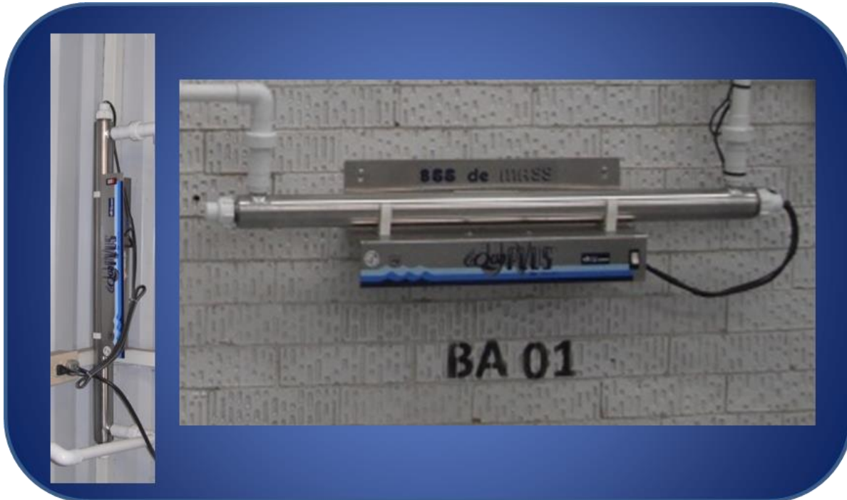
Figura 49. Muestra las lámparas de Luz UV de las plantas purificadoras.
