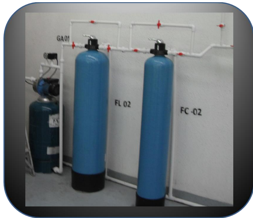
Figura 58. Muestra el nuevo filtro multicapa de lecho profundo FL-01 en Campus II.
