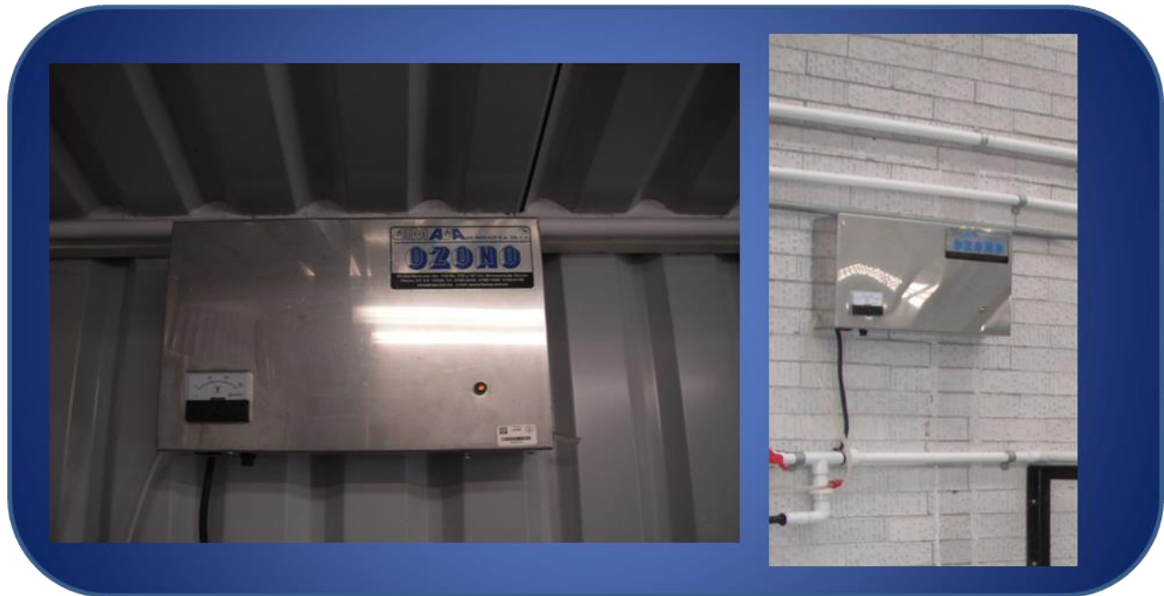
Figura 50. Muestra los generadores de ozono BA-01 de ambas plantas purificadoras.
