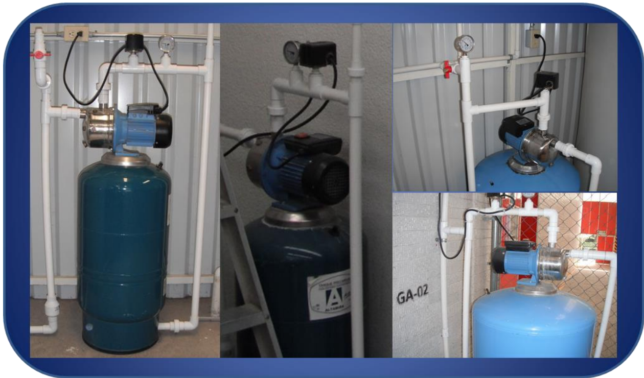
Figura 51. Muestra los sistemas hidroneumáticos GA-01 y GA-02 de las plantas purificadoras.
