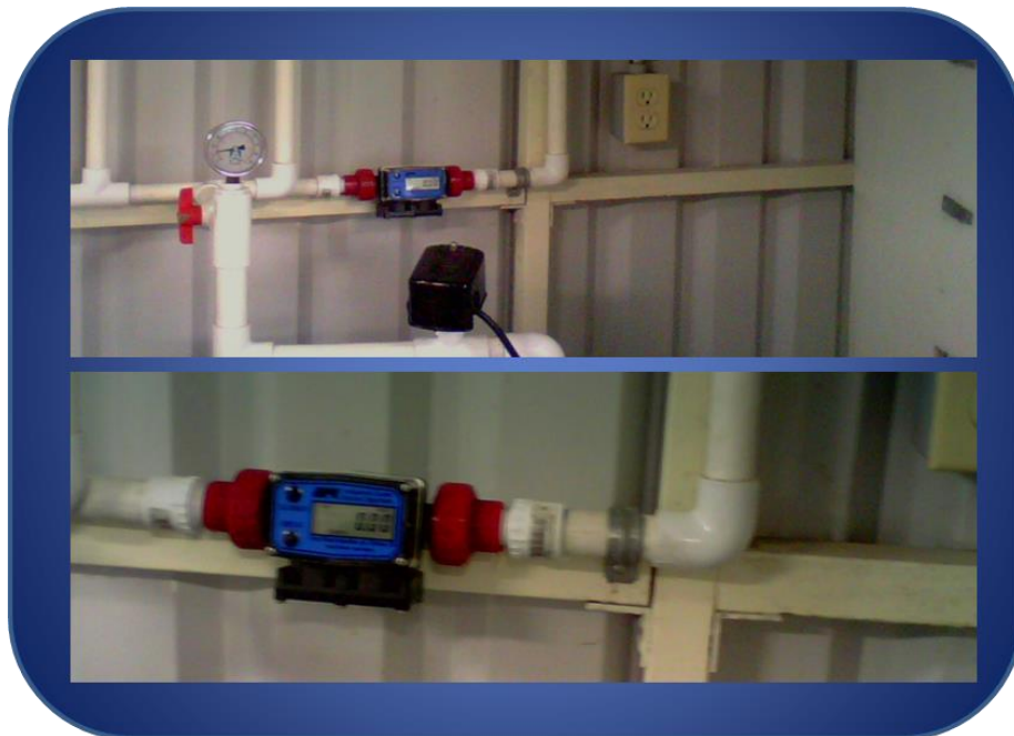
Figura 63. Muestra el medidor/cuantificador de flujo de Campus I.
