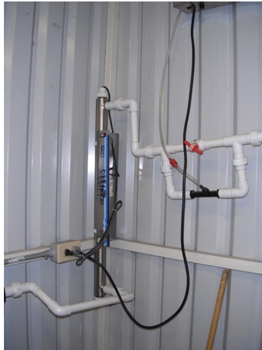
Figura 38. Muestra el paso de agua por la lámpara de luz UV de la Planta Purificadora de Campus I.
