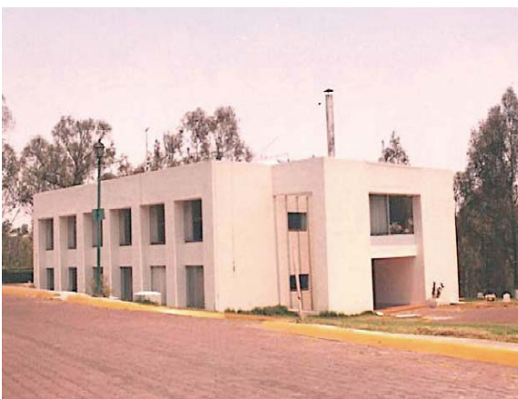
Edificio administrativo, salas de velación y crematorio del ISSSTE.
