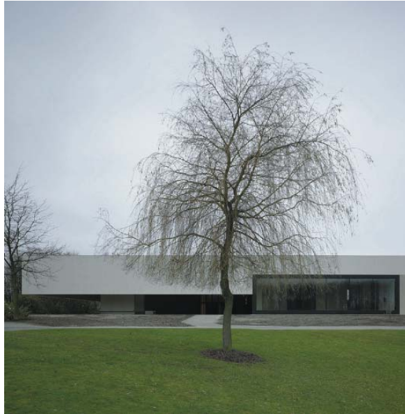
2 Fachada del Crematorio.
