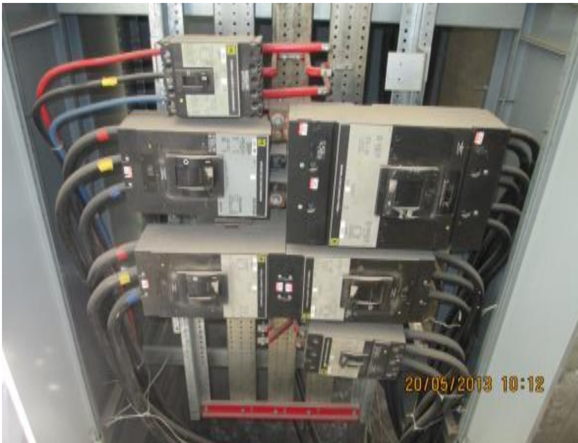
Ilustración 84. Tablero sin tapa
