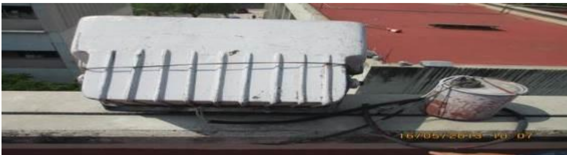
Ilustración 82. Componentes de luminaria expuestos
