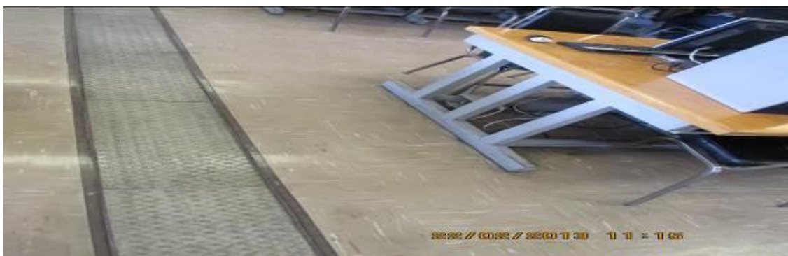
Ilustración 31. Alimentación bajo piso
