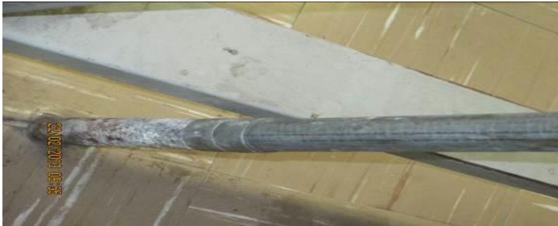
Ilustración 25. Canalización oxidada
