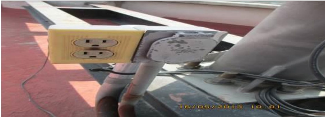
Ilustración 80. Contacto para uso en interiores
