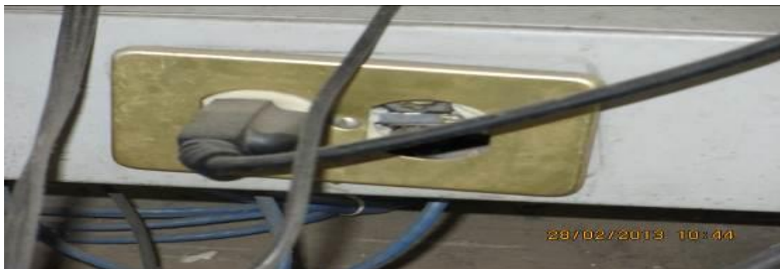
Ilustración 37. Contacto dañado
