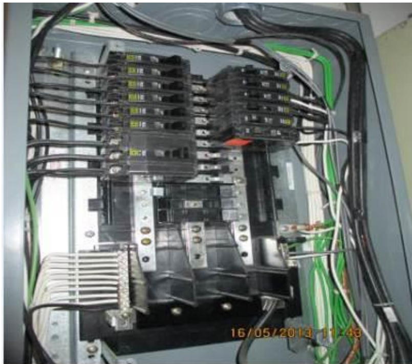
Ilustración 87. Tablero en bien peinado y que respeta código de colores
