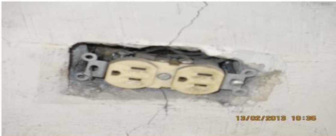
Ilustración 27. Contacto sin tapa y espacio sin resanar
