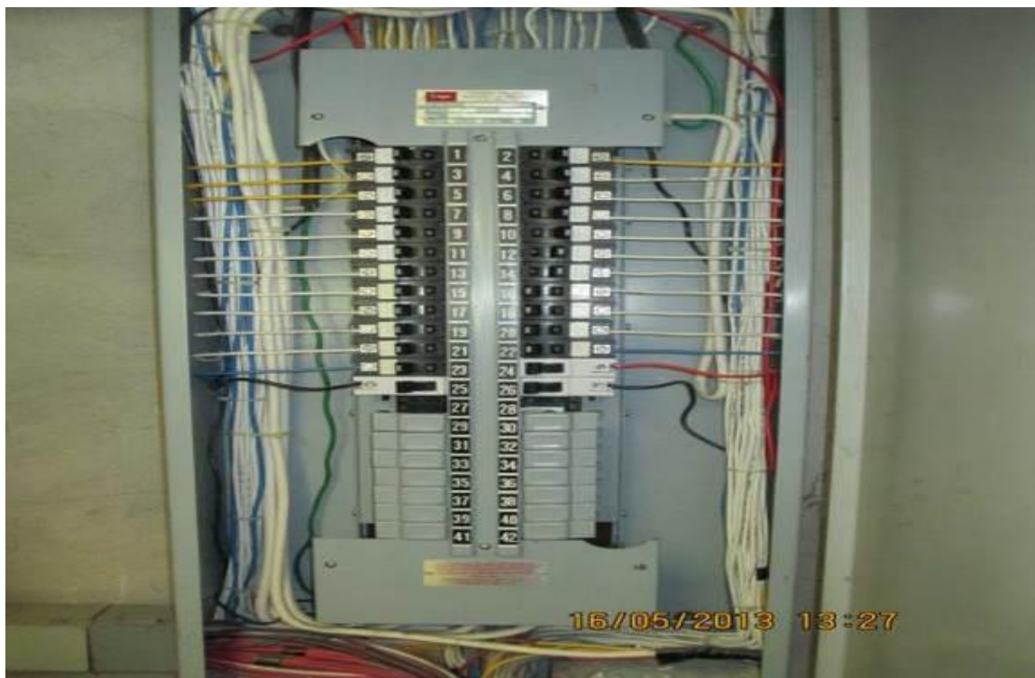
Ilustración 66. Tablero donde no se respeta código de colores
