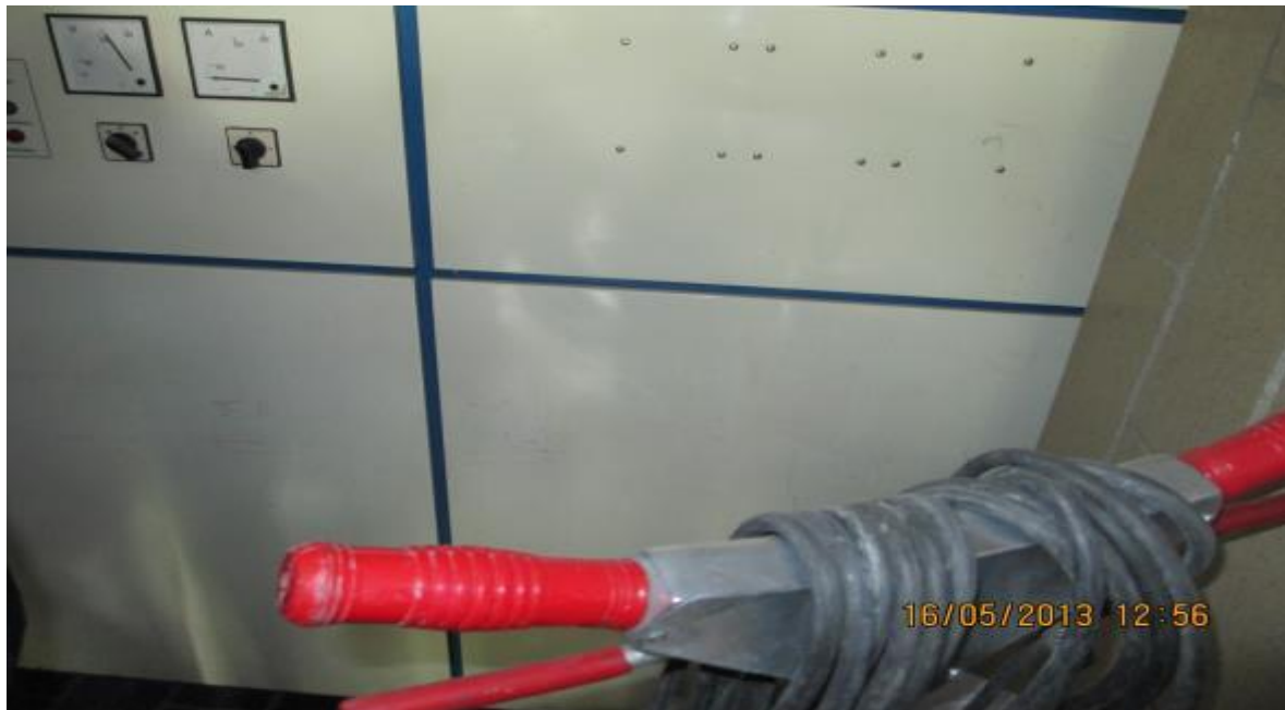
Ilustración 71. Equipos de limpieza en cuartos eléctricos
