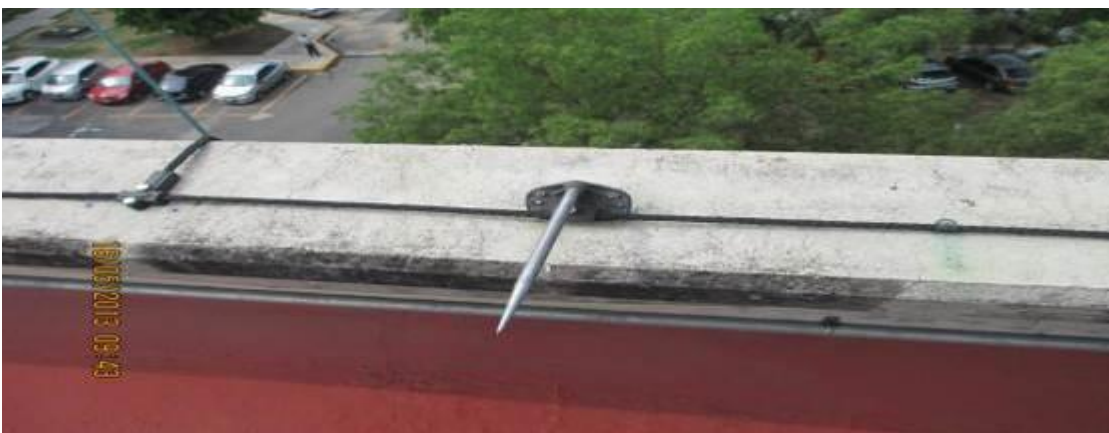
Ilustración 75. Punta de pararrayos sin sujetar
