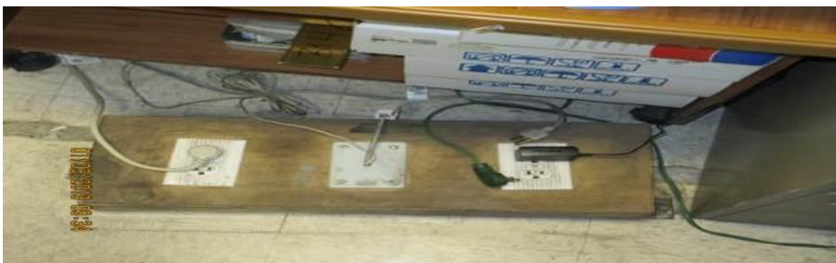
Ilustración 58. Contactos provisionales empotrados sobre madera
