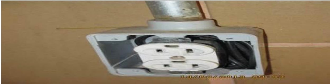
Ilustración 62. Contacos si tapa
