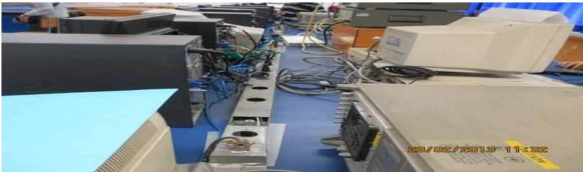
Ilustración 48. Mesas sin alimentar y uso de alimentadores provisionales
