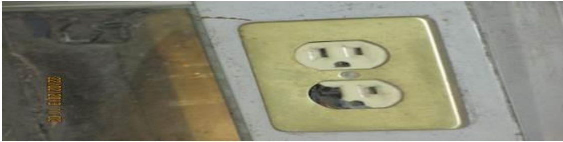
Ilustración 32. Contacto roto
