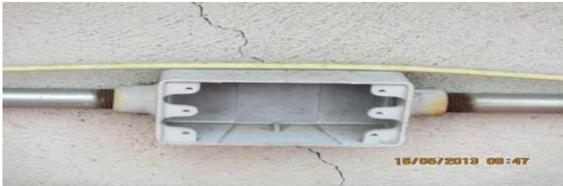
Ilustración 77. Canalizaciones sin utilizar
