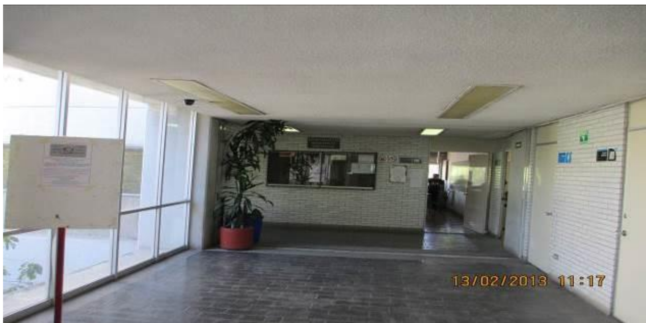
Ilustración 7. Área de vestíbulo, segundo piso
