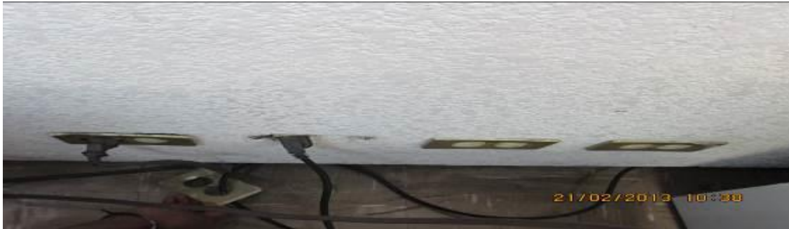
Ilustración 39. Contacto sin tapa
