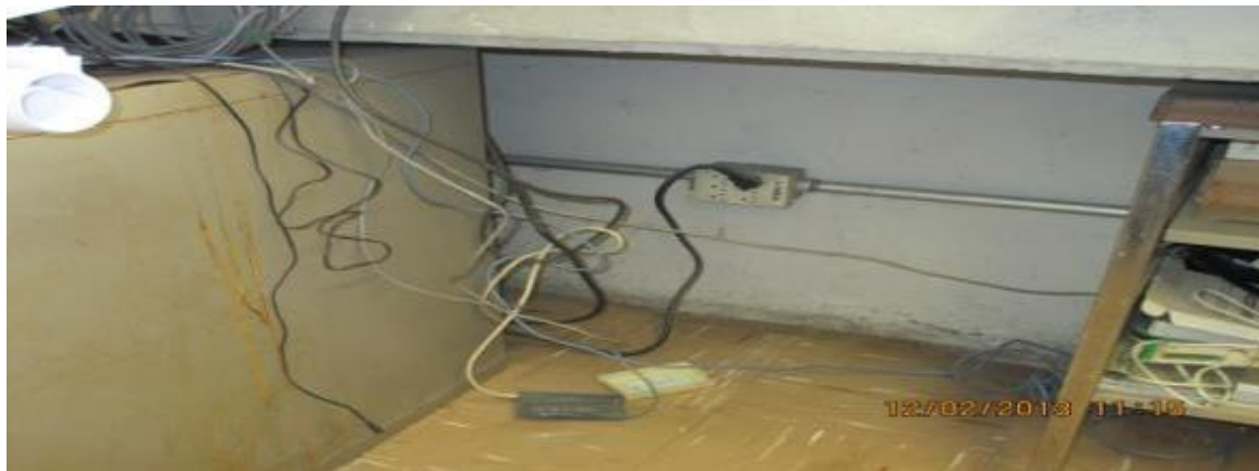
Ilustración 12. Uso de extensiones
