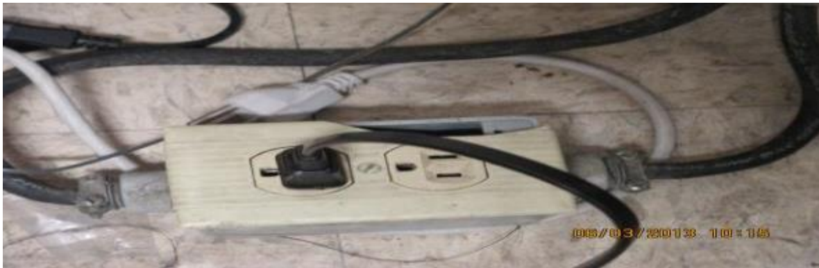
Ilustración 56. Contactos provisionales con tapa rota
