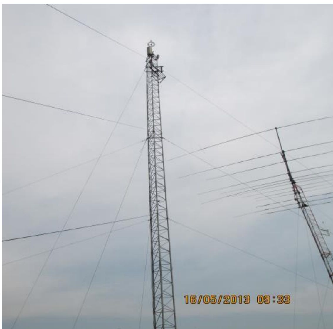
Ilustración 73. Sistema de protección contra tormentas eléctricas
