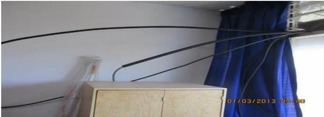
Ilustración 53. Entrada de alimentadores por una ventana
