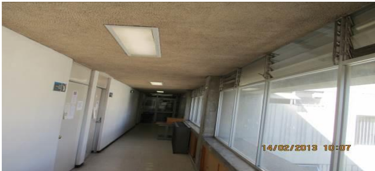
Ilustración 8. Pasillo (área de laboratorios), tercer piso
