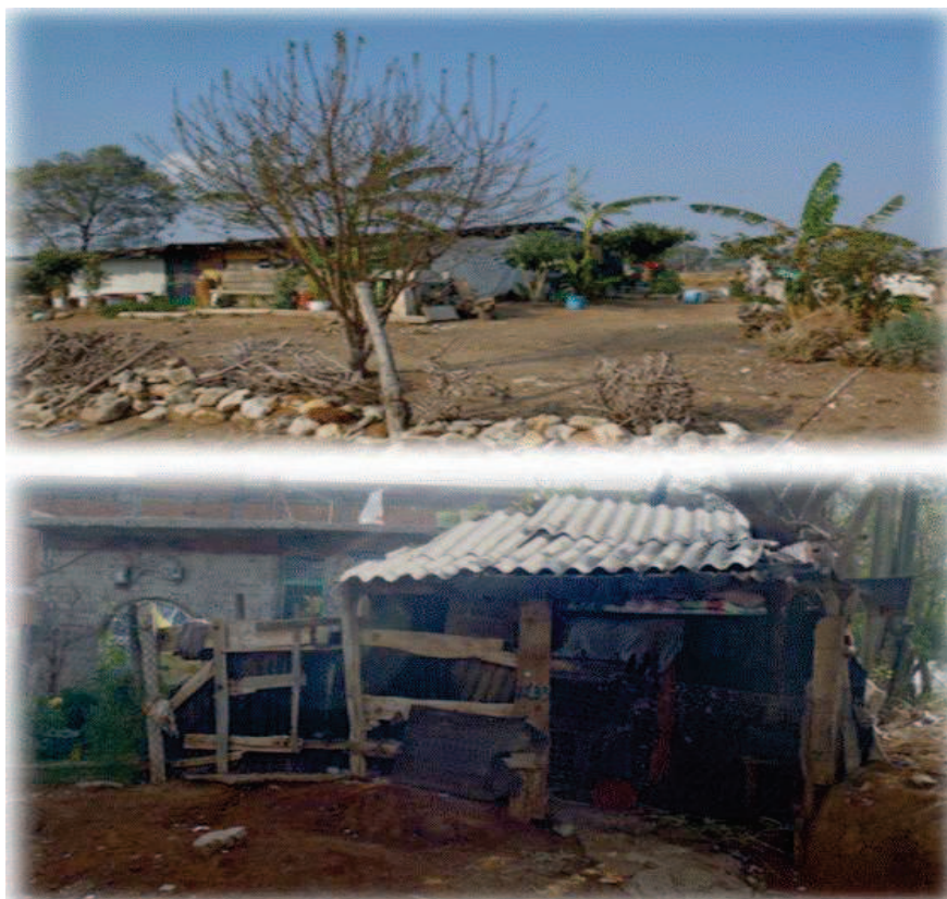
Imagen 15. Vivienda en la localidad El Durazno (marzo de 2011, tomado de trabajo de campo).
