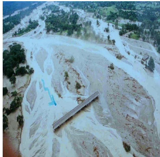
Figura 1.9 Puente "Cintalapa", Huixtla- Tapachula, Chiapas
