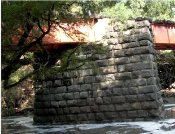
Figura 2.9 Pila central, construcción en mampostería
