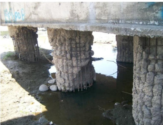
Figura 1.10 Puente "Pijijiapan I", Tapanatepec- Talismán, Oaxaca
