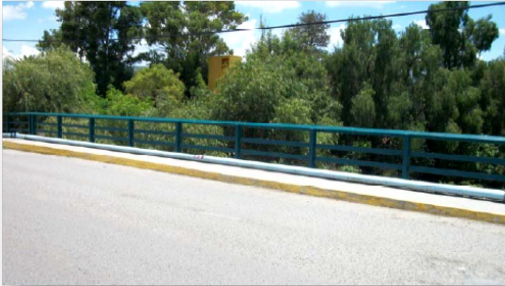
Figura 2.23 Carpeta asfáltica, paso peatonal y parapeto de acero
