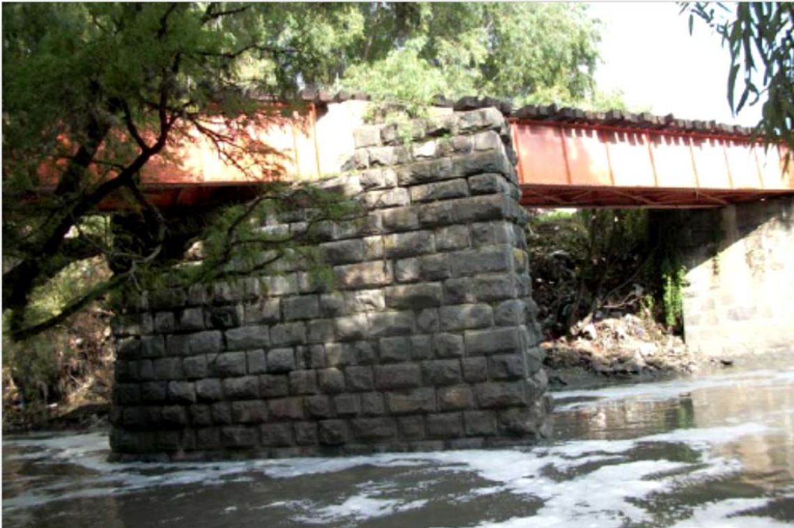
Figura 2.2 Puente ferroviario “El Recinto”, superestructura de acero con apoyos de mampostería
