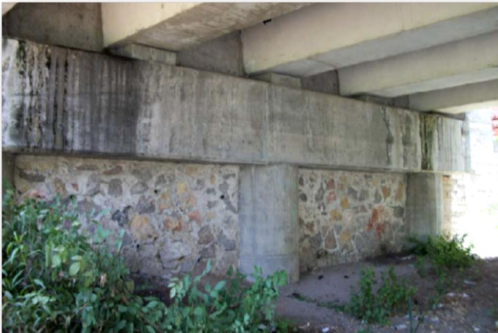
Figura 2.29 Apoyo extremo, conformada por cabezal sobre 3 columnas circulares
