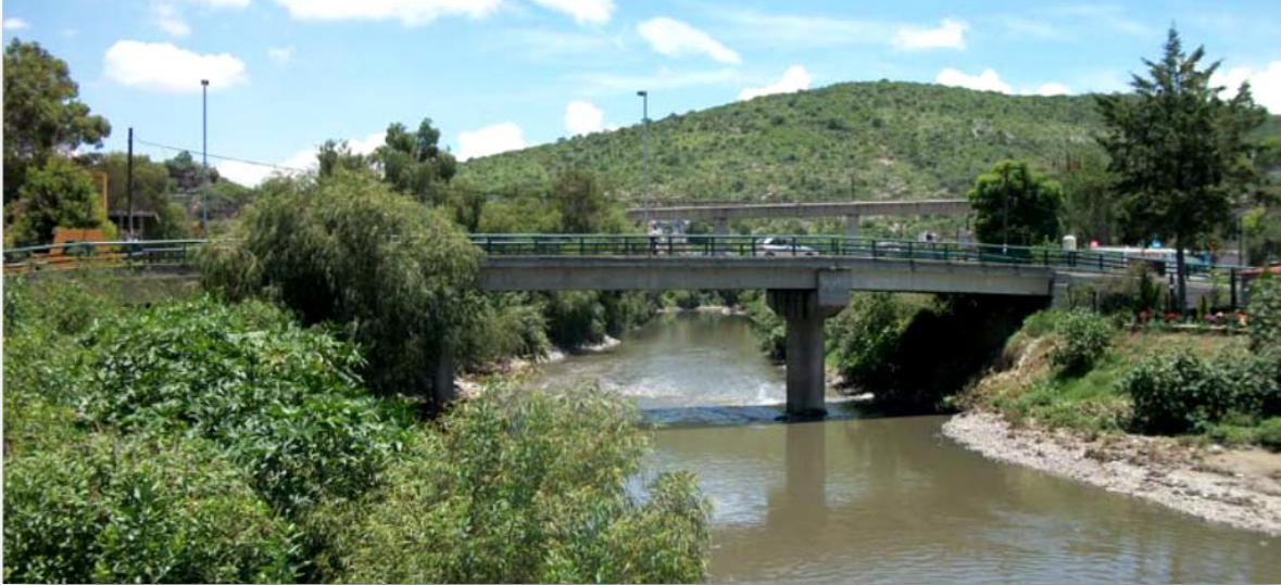
Figura 2.21 Vista general, puente "5 de mayo"
