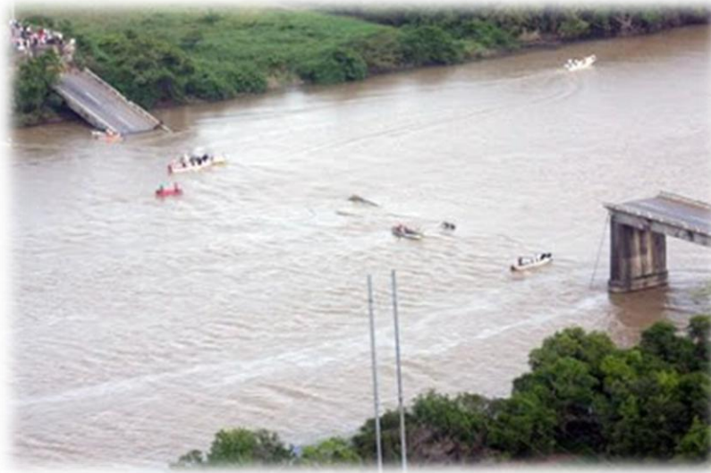
Figura 1.3 Fallo del puente Tonalá, sobre el río Tonalá, Veracruz-Tabasco
