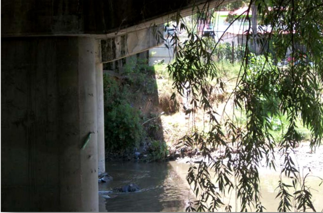
Figura 2.28 Pilas, cabezales y taludes de acceso contruidos en tierra
