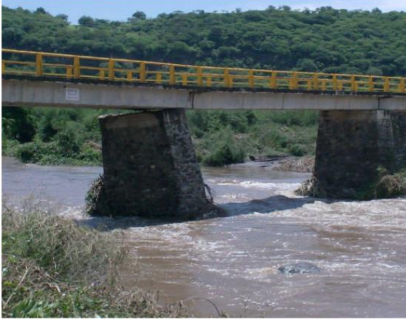
Figura 1.12 Puente “Nexpa”, Morelos
