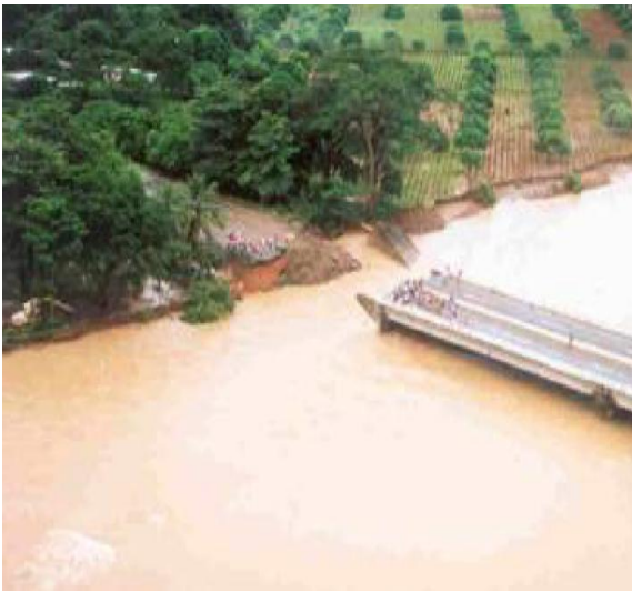
Figura 1.8 Puente "Huehuetán", Huixtla- Tapachula, Chiapas
