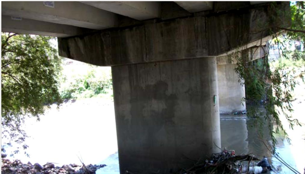
Figura 2.27 Pilas, formadas por un cuerpo rectangular con narices redondeadas sobre el cual se apoya un cabezal de concreto reforzado.
