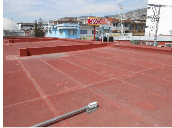
Ilustración 16, Charcos en la azotea.
