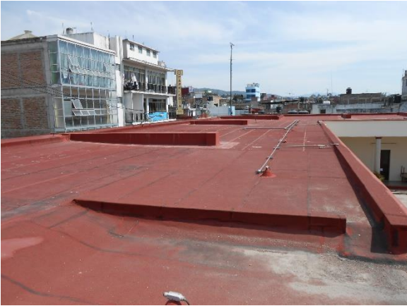
Ilustración 15. Charcos en la azotea.
