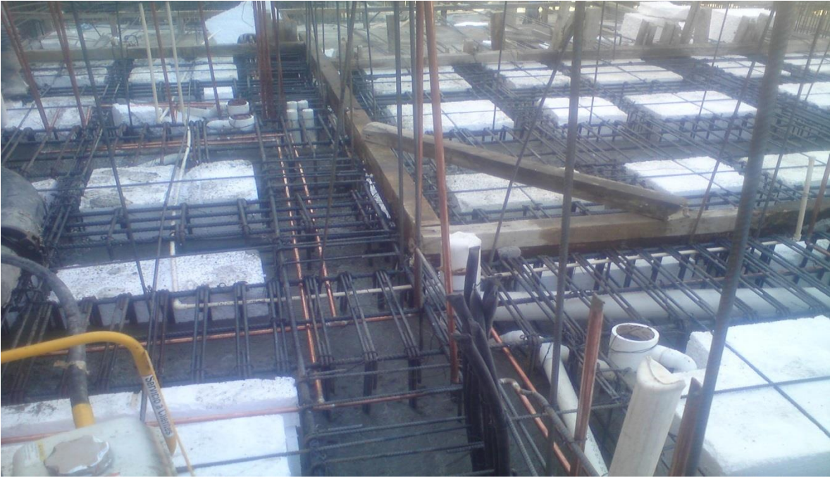
Foto 23. Colado de losa aligerada.
