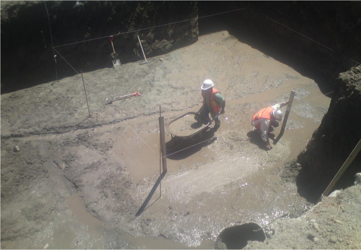
Foto 16. Colado de plantilla.
