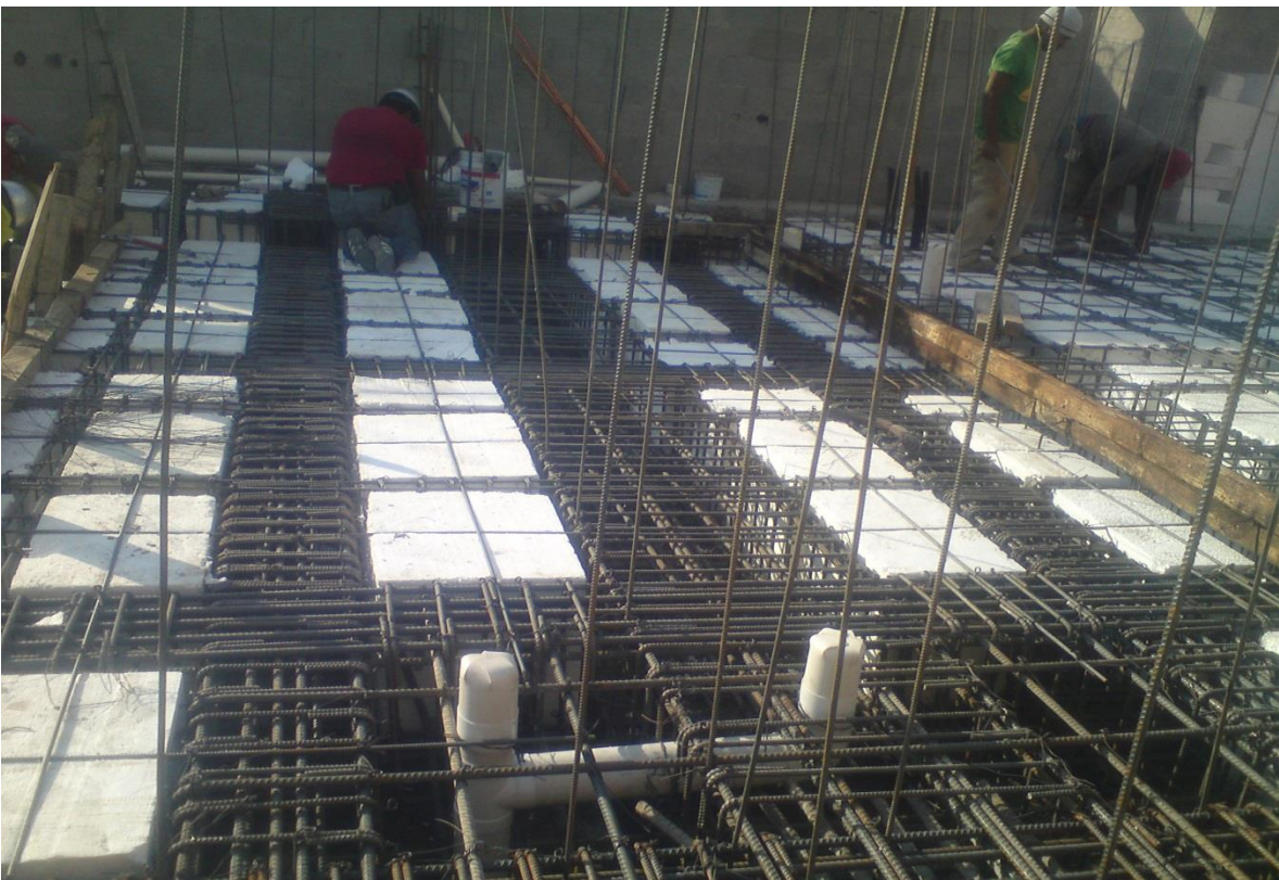
Foto 24. Ramaleo de instalaciones hidrosanitarias.
