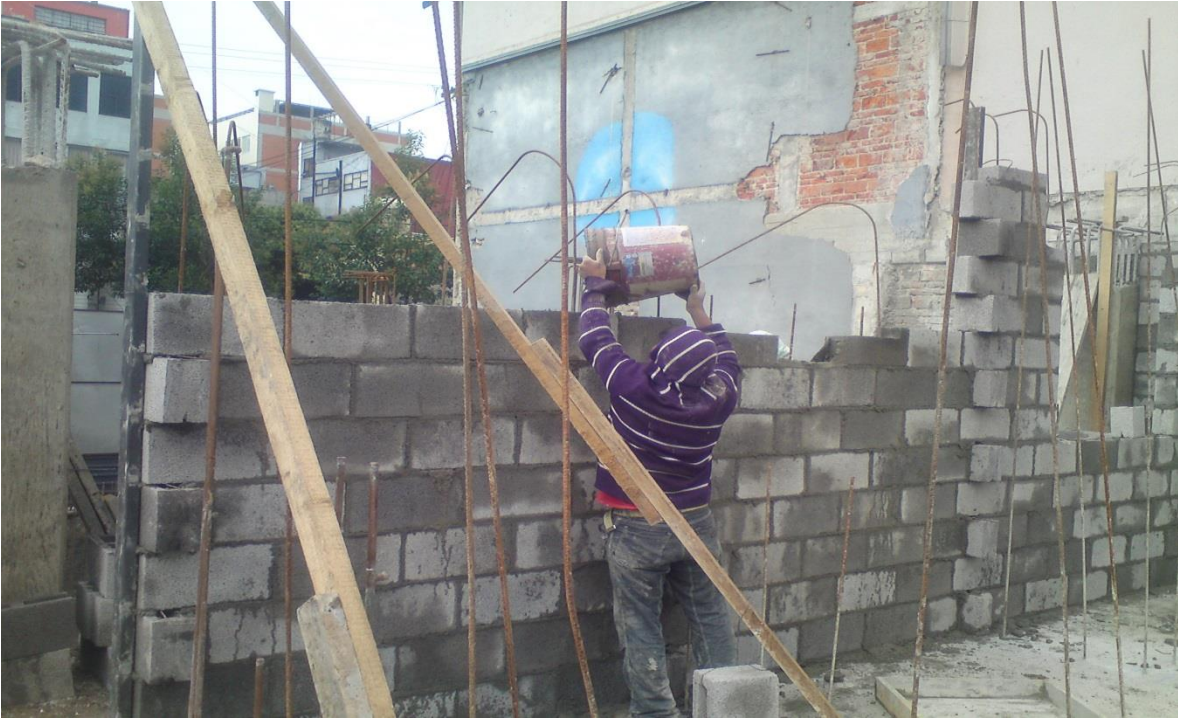
Foto 33. Colado de huecos en muros de block.
