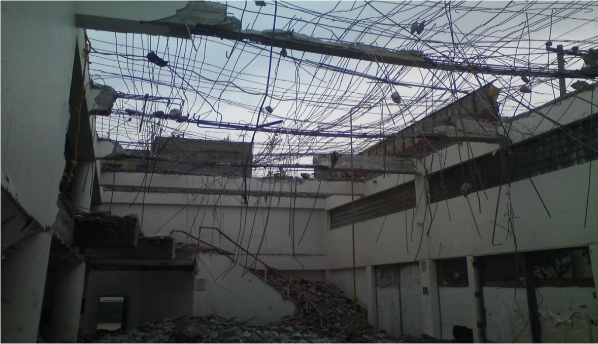
Foto 6. Demolición de losas existentes.
