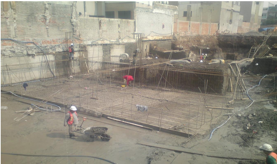
Foto 17. Armado de traves de cimentación.
