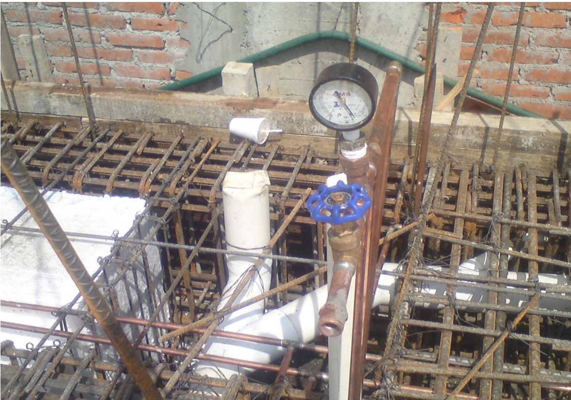
Foto 34. Prueba de ramaleos hidráulicos.
