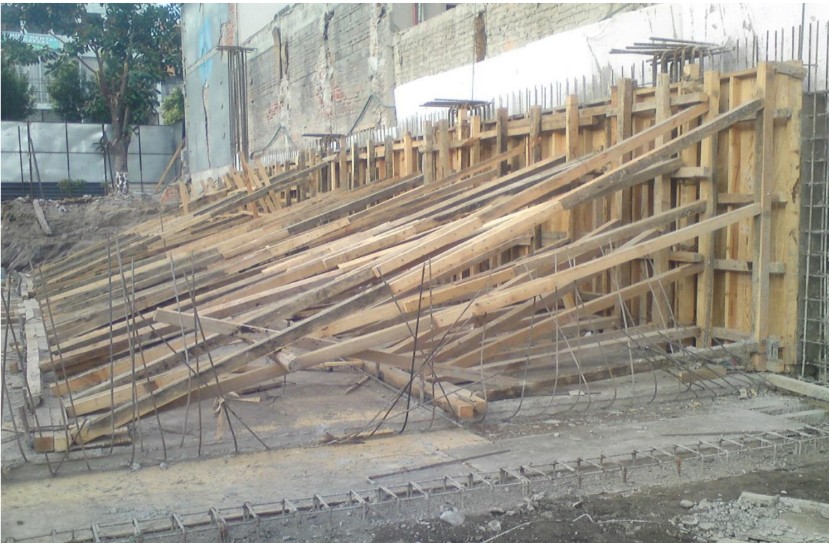
Foto 22. Cimbra de muro de contención perimetral.
