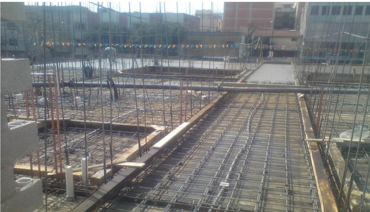
Foto 30. Colado de losa de entrecimpo.
