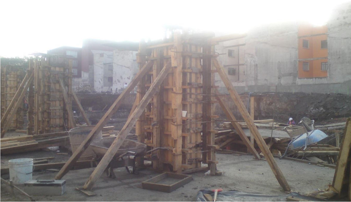
Foto 21. Cimbra de columnas de 0.60x0.40 de sección.
