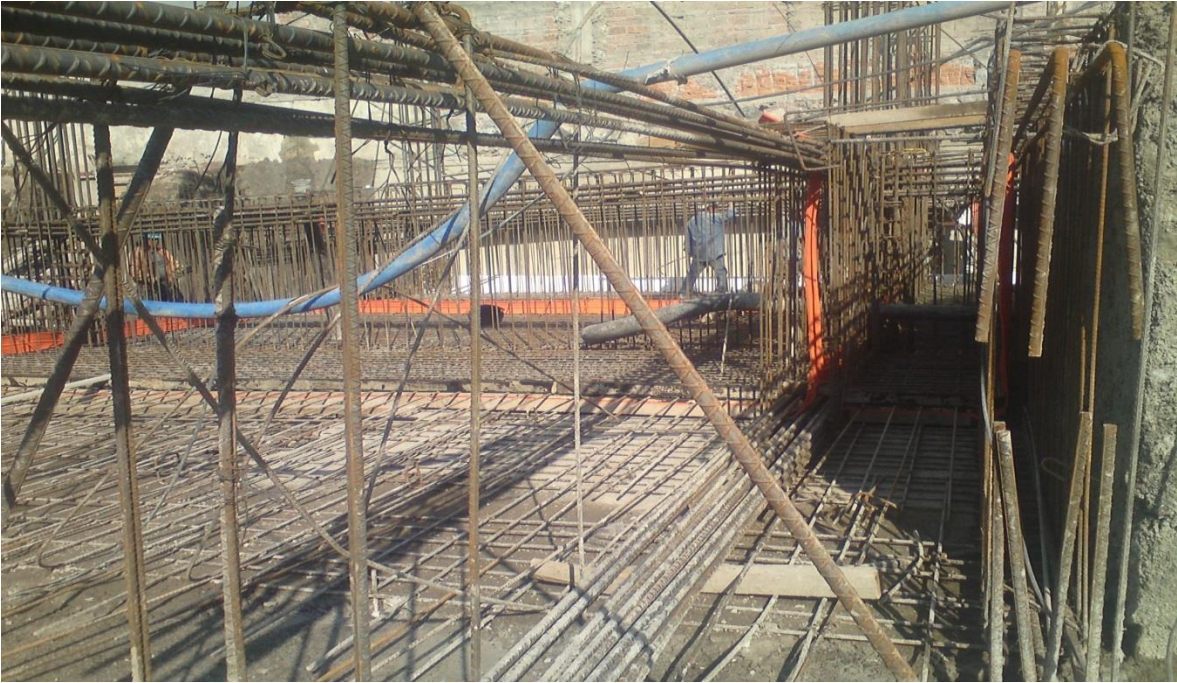
Foto 20. Colado de losa fondo de cimentación.
