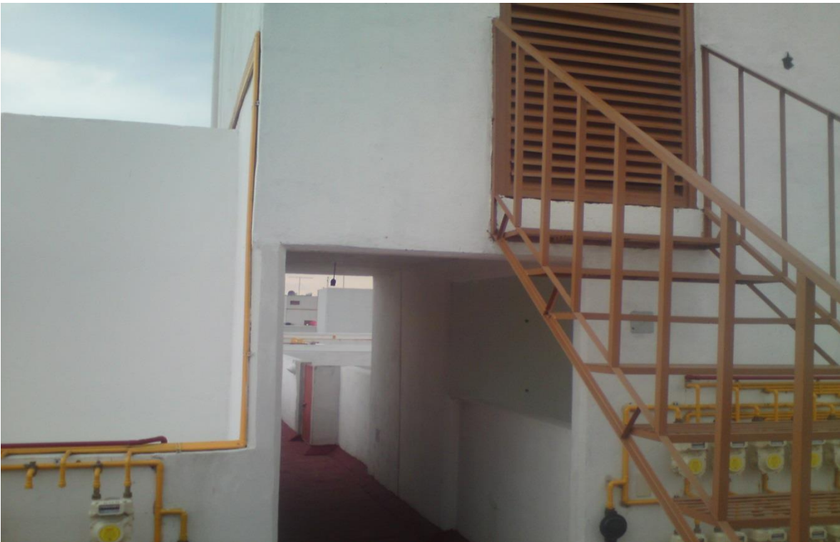
Foto 32. Cuarto de máquinas de elevador en azotea.
