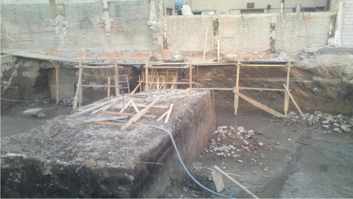
Foto 12. Áreas sin cimentación.
