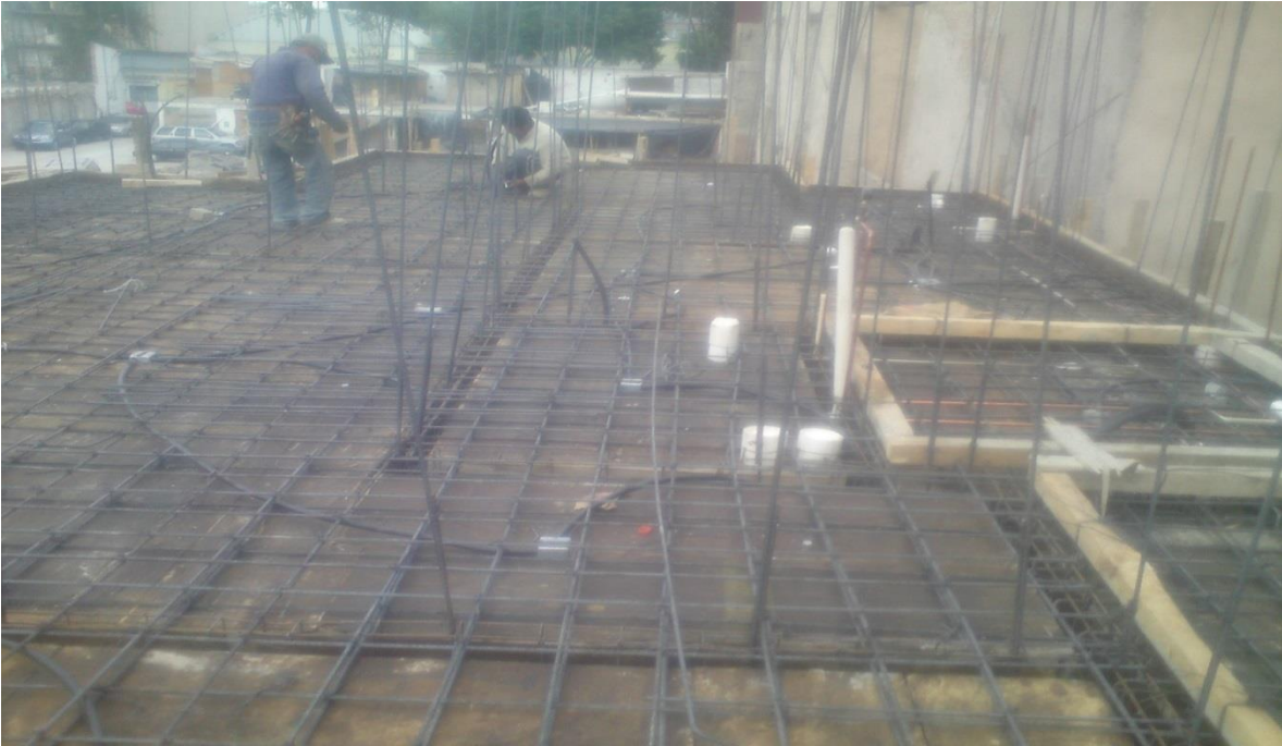
Foto 29. Losa de entrecimpo.
