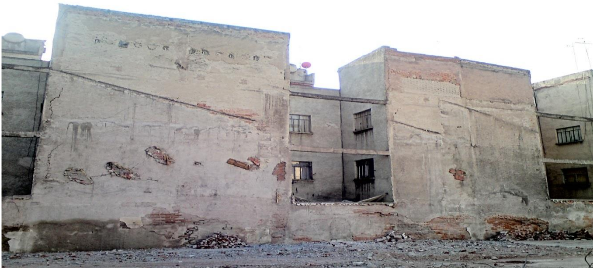
Foto 14. Muros de edificios colindantes.
