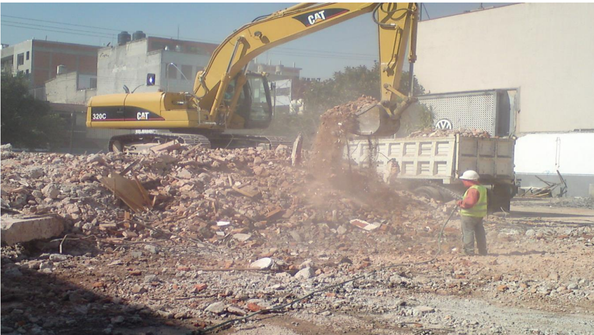
Foto 7. Carga con equipo mecánico de material de demolición.
