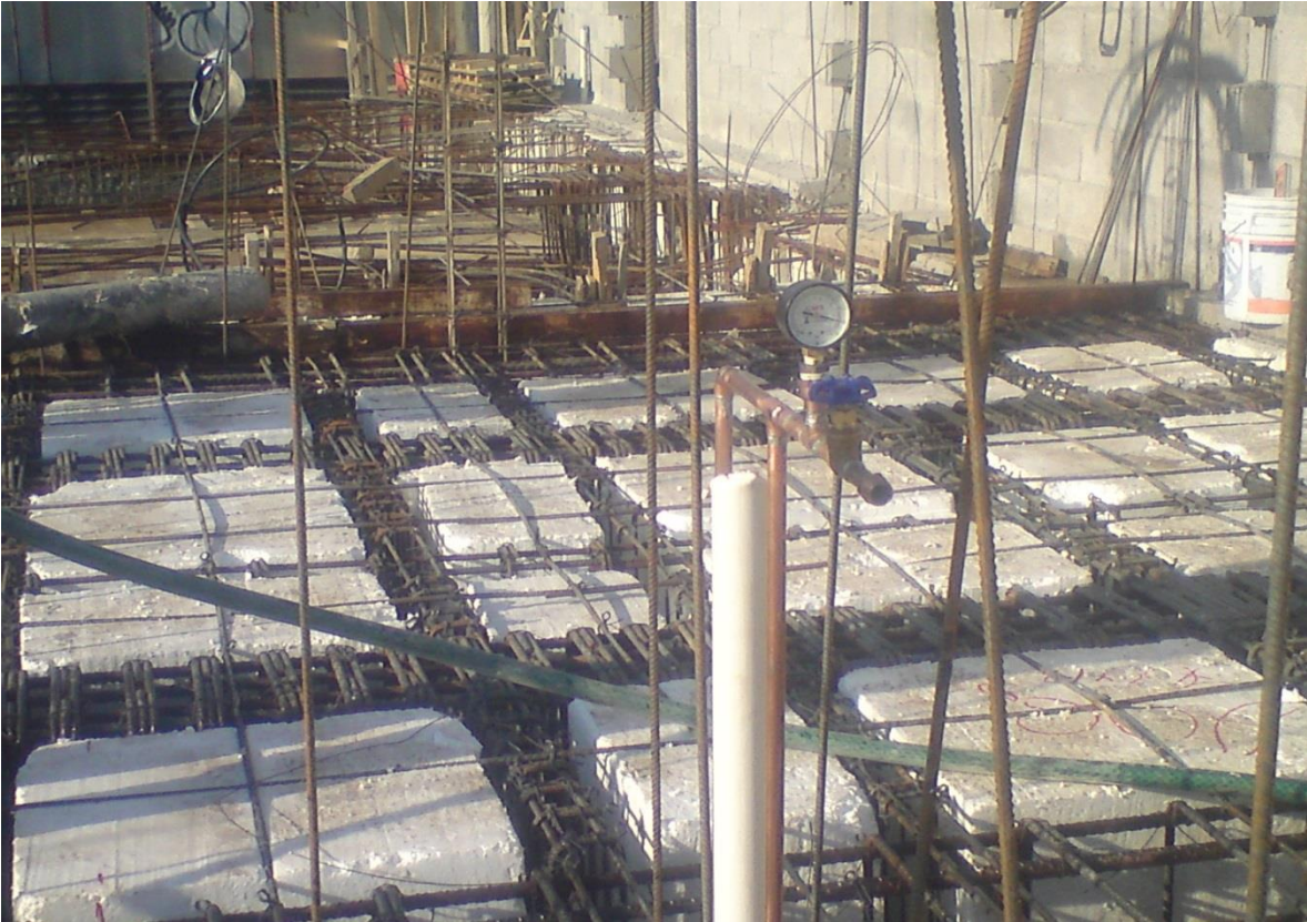
Foto 25. Losa plana aligerada.
