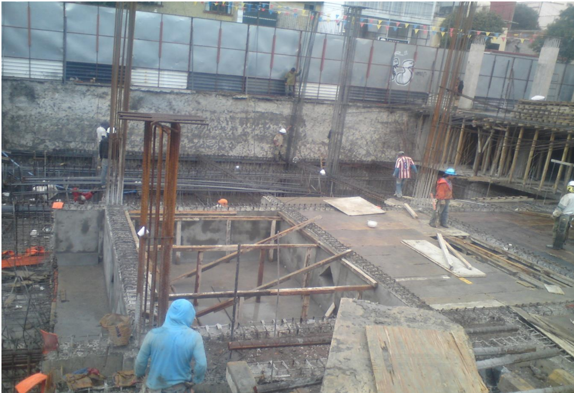
Foto 19. Cimbra de losa tapa del cajón de cimentación.
