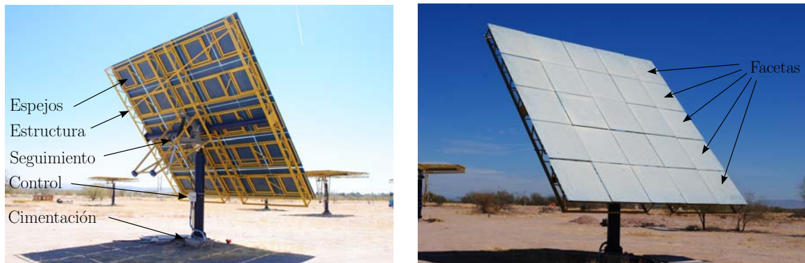
Figura 2.7: Componentes de un helióstato, CEToC.
