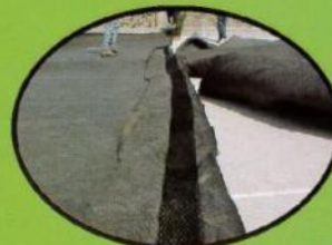
Traslape entre rollos de PAVIDREN®
