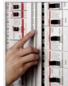
Cubierta aislante frontal
