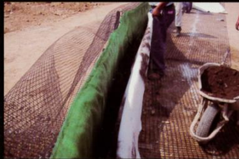
La tierra preparada y la semilla se colocan atrás de la malla antierosión
