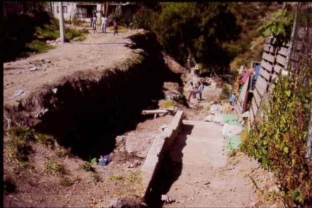
ANTES: corte con problemas de erosión, que requiere ganar espacio para construir una vialidad
