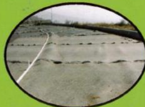
Instalación de rollos de PAVIDREN®
