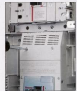
Cubierta aislante Interruptor Principal
