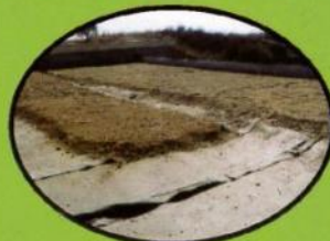
Colocación de tierra vegetal
