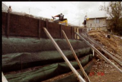
Compactación del relleno reforzado contra una cimbra provisional
