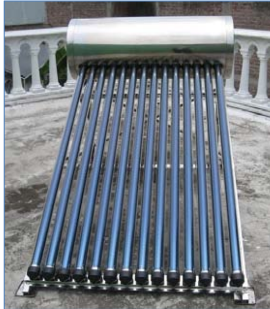
Figura 9. Calentador solar de tubos al vacío con termostanque de almacenamiento integrado.
