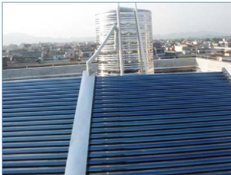
Figura 10. Calentador solar de al vacío. Sistema con cabezal para grandes proyectos de abastecimiento de agua. El tanque de almacenamiento se encuentra aparte del campo de colectores.
