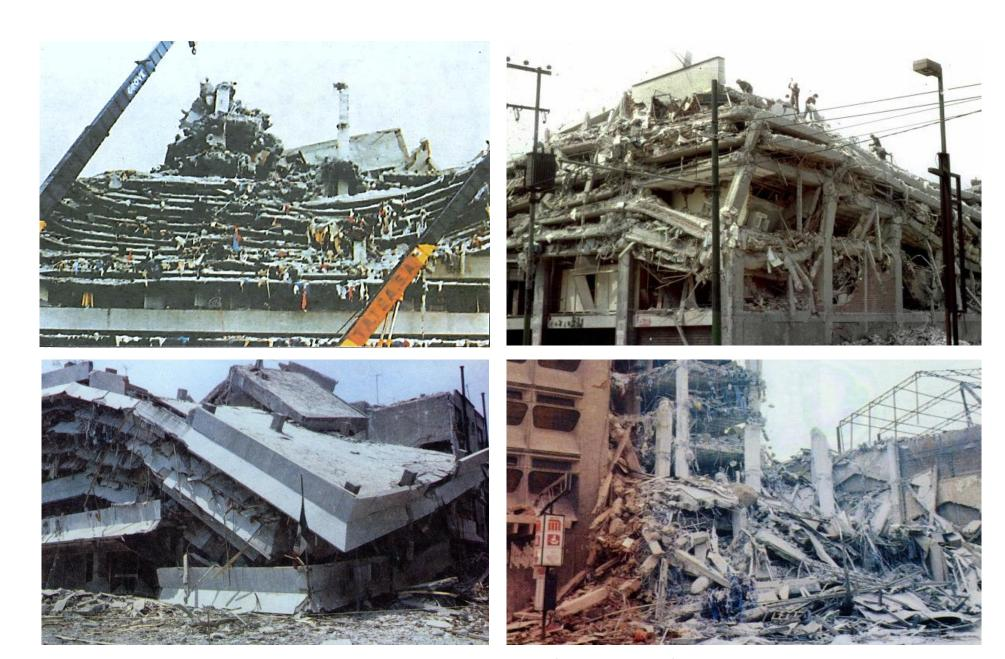
Figura I-5 Daños debidos al sismo de septiembre de 1985 en diversos edificios de la Ciudad de México construidos con losas planas.
