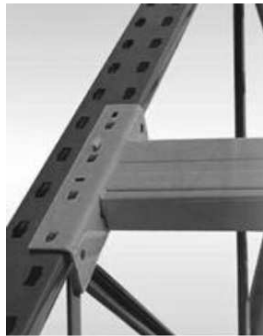
Fig. 1.8 Conexión atornillada viga-columna [3]
