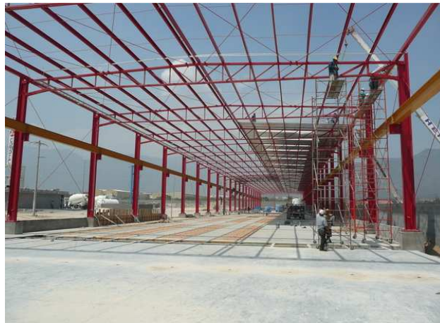
Fig. 3.1 Nave industrial con cubierta a base de armaduras
