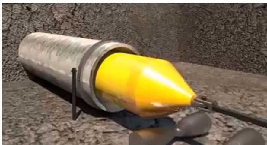
Figura 3.7. Recubrimiento interior de tuberías por halado
