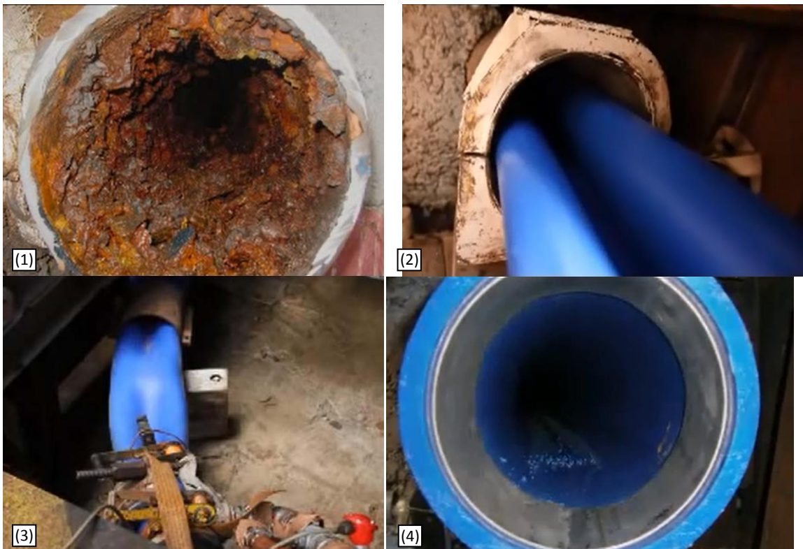
Figura 3.10. Proceso de revestimiento con tubo flexible
