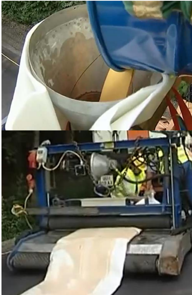
Figura 3.14. Impregnación de la resina epóxica
