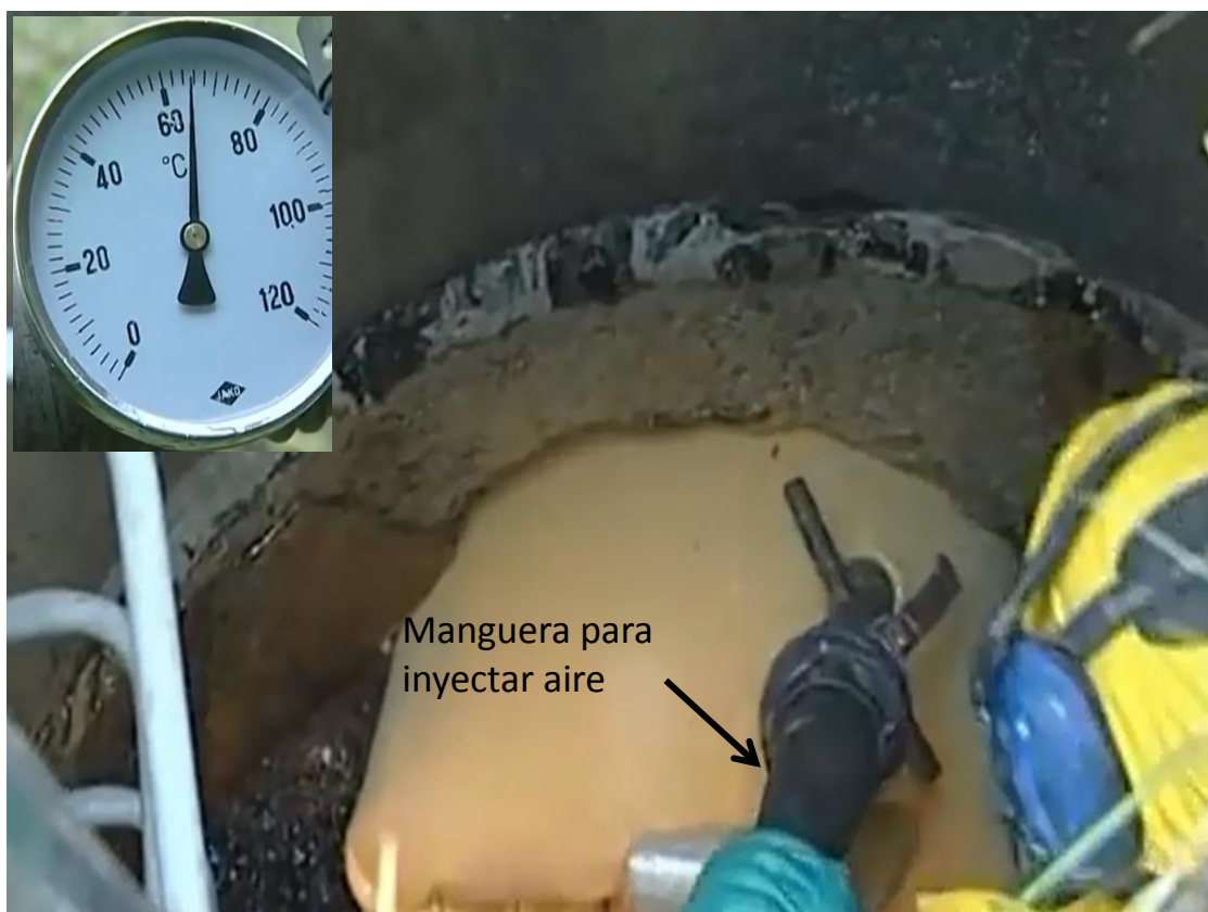
Figura 3.16. Inyección de vapor
