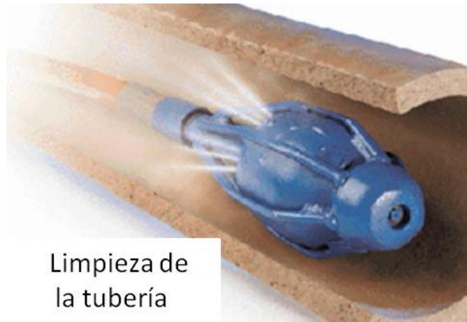
Figura 3.12. Limpieza de la tubería con un chorro a alta presión
