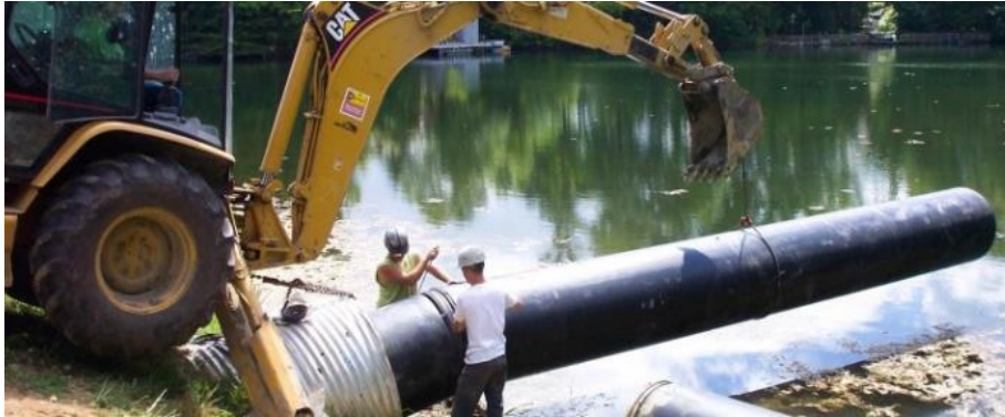
Figura 3.8. Recubrimiento interior por empuje
