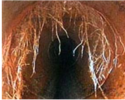
Figura 2.9. Raíces que penetraron por aberturas microscópicas
