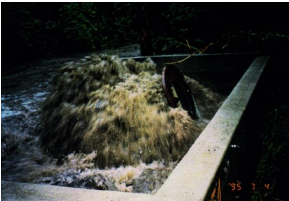
Figura 4.17. Voladura de la tapa de un pozo de visita del drenaje en la Ciudad de Edmonton, Canadá
