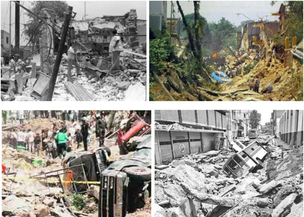
Figura 4.23 Fotografías del daño causado por la explosiones
