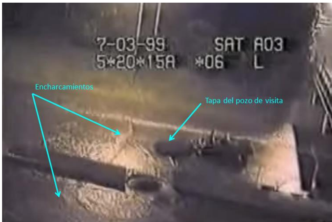
Figura 4.20. Encharcamientos causados por el Géiser.
