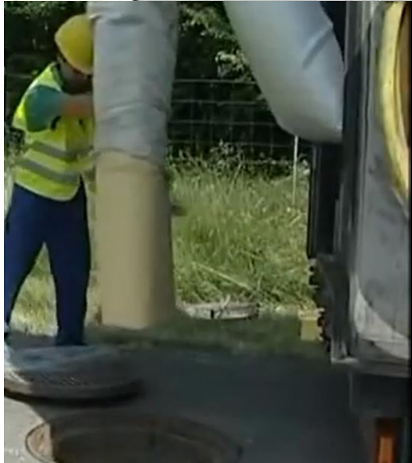
Figura 3.15. Inyección de aire e inserción de la manga
