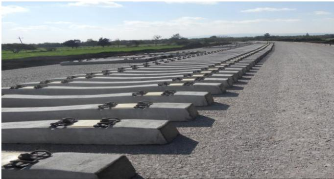
**Imagen 65, aquí se muestra como se colocan los durmientes sobre el terraplén, Fuente: [libramiento ferroviario Querétaro- Celaya](#).**
