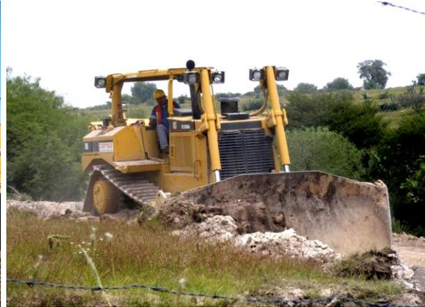
Imagen 54,55: En estas imágenes se puede mostrar el trabajo que se realiza para el despalme del derecho de una vía fuente:
