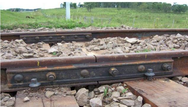
**Imagen 64: En esta foto se muestra la Junta de vía en rieles de perfil, fuente: [libramiento Celaya Guanajuato.](#)**
