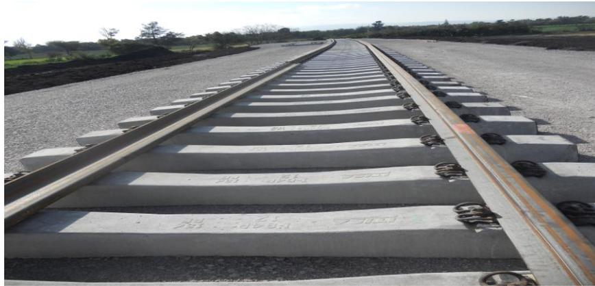
Imagen 60: En esta foto se puede mostrar la colocación de vía que se va haciendo durante el proceso constructivo de una vía férrea, fuente: [libramiento ferroviario Celaya Guanajuato](#)
