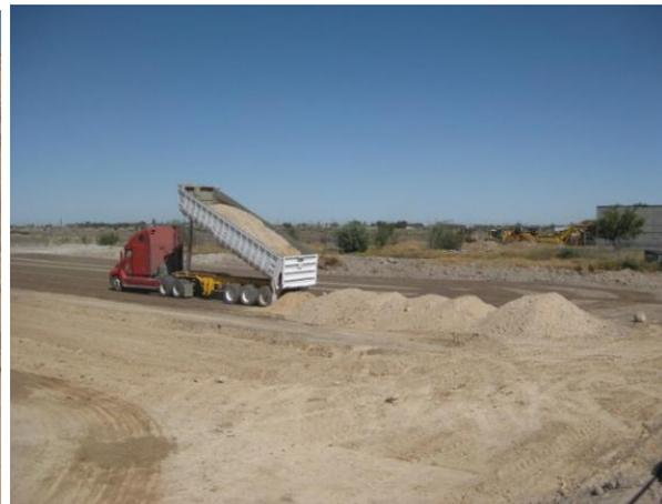
Imagen 58,59: En estas imágenes se puede mostrar el trabajo que se realiza para el transporte de materiales, así como el transporte de agua empleada para un terraplén. Fuente: <http://www.ismconstrucciones.com/Secciones.aspx?ld=18>
