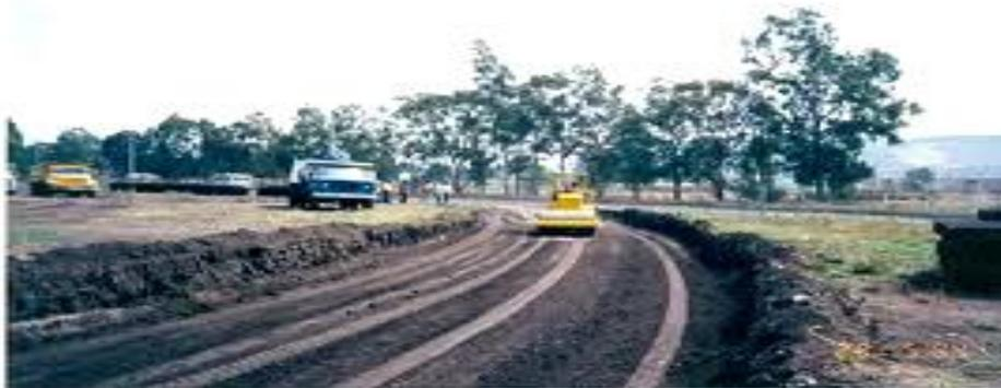
Imagen 18: Esta foto muestra la Construcción de Terracerías preparando para asentar vía. Fuente: [víahttp://www.gamasolucionesqueretaro.com/Servicios/Terracer%C3%ADas/tabid/65/Default.aspx](http://www.gamasolucionesqueretaro.com/Servicios/Terracer%C3%ADas/tabid/65/Default.aspx)
