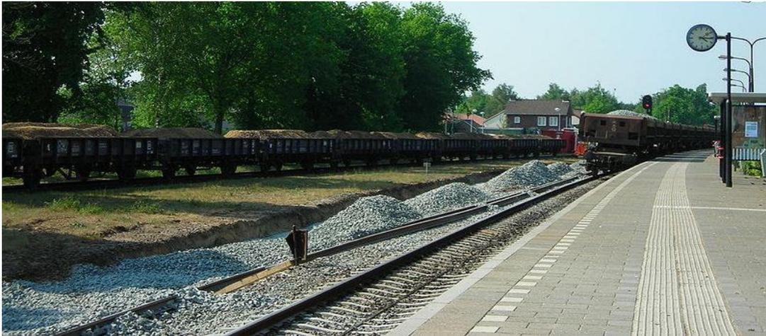
Imagen 34 vaciado de balasto sobre vía, fuente: [temas de selectos de ferrocarriles UNAM](#)
