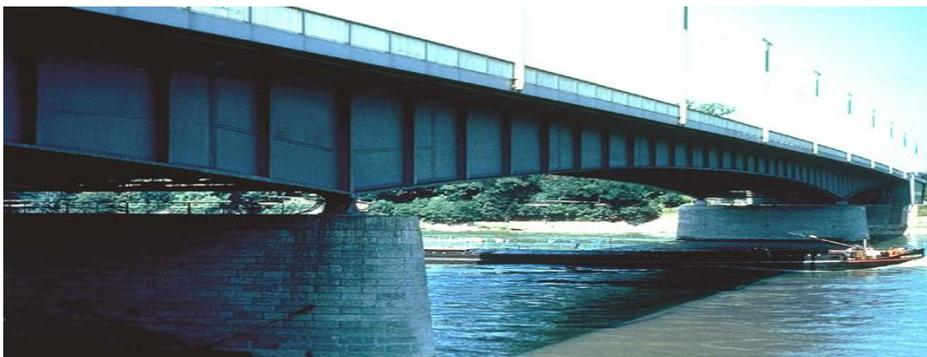
Foto 49, ejemplo de puente en vigas, fuente: [http://labrm.mecaest.etsii.upm.es/media/IMG0035\\_secc\\_var\\_full.jpg](http://labrm.mecaest.etsii.upm.es/media/IMG0035_secc_var_full.jpg)
