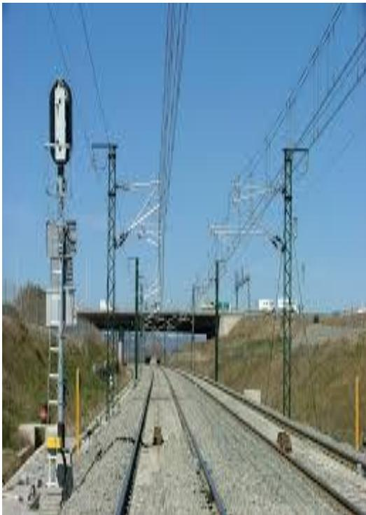
En ferrocarriles se denomina catenaria a la línea aérea de alimentación que transmite energía eléctrica a las locomotoras u otro material motor.
