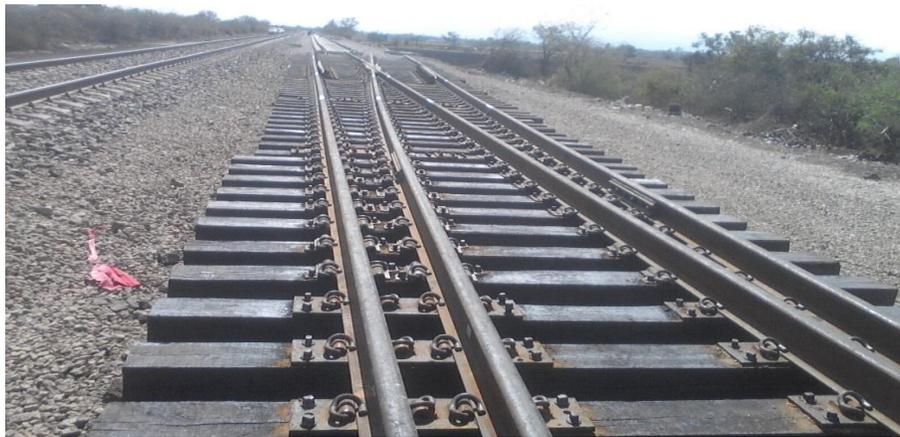
Imagen 61: En esta foto se muestra la estructura de una vía ferrea ya terminada, fuente: [libramiento ferroviario Celaya Guanajuato](#).
