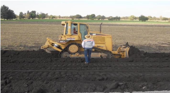
**imagen 55:** En esta imagen se muestra como se pasa la maquinaria para la construcción de un terraplén, fuente: [libramiento ferroviario Celaya Guanajuato.](#)
