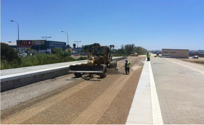
imagen 57: En esta imagen se muestra el material para sub-balasto y parte de la estructura del terraplén: [libramiento ferroviario Celaya Guanajuato](#)
