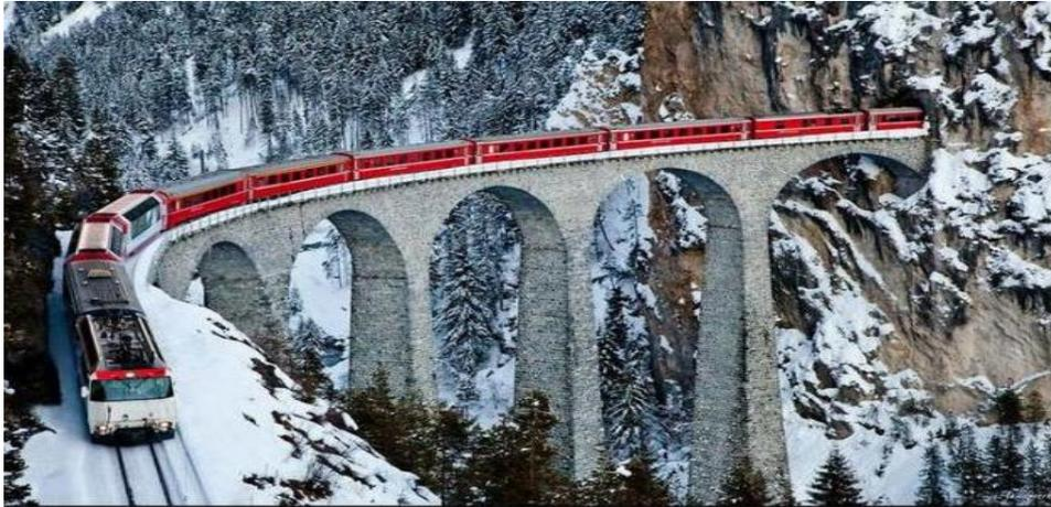
Imagen 49 ejemplo de puente en arco, fuente: [temas selectos ferroviario UNAM](#)
