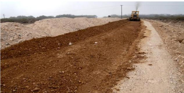
**imagen 56:** En esta imagen se muestra como se pasa la motoconformadora para la la formación de la capa subyacente: [libramiento ferroviario Celaya Guanajuato](#)
