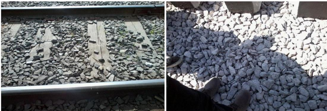
Imagen 35,36, en estas fotos se muestra el tendido de balasto sobre la vía, fuente: [temas selectos de ferrocarriles UNAM](#)
