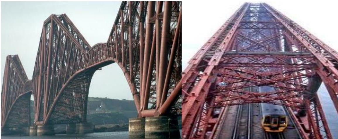
Fotos 50, 51 puente ferroviario tipo cantilever, fuente: [temas selectos ferroviario UNAM](#)
