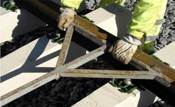
Imagen 69: Trabajos de alineamiento y nivelación de una vía férrea, fuente: [temas selectos de ferrocarriles UNAM](#)
