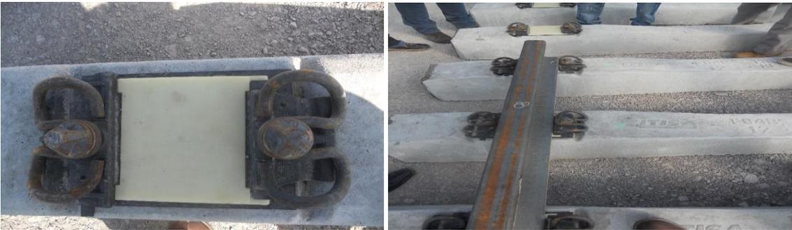
**Fotos 62,63: En estas fotos se muestran como se colocan las placas metalicas sobre os durmientes y se ve como se monta la vía sobre los durmientes y como hace funcion la placa, fuente: [libramiento ferroviario Celaya Guanajuato.](#)**
