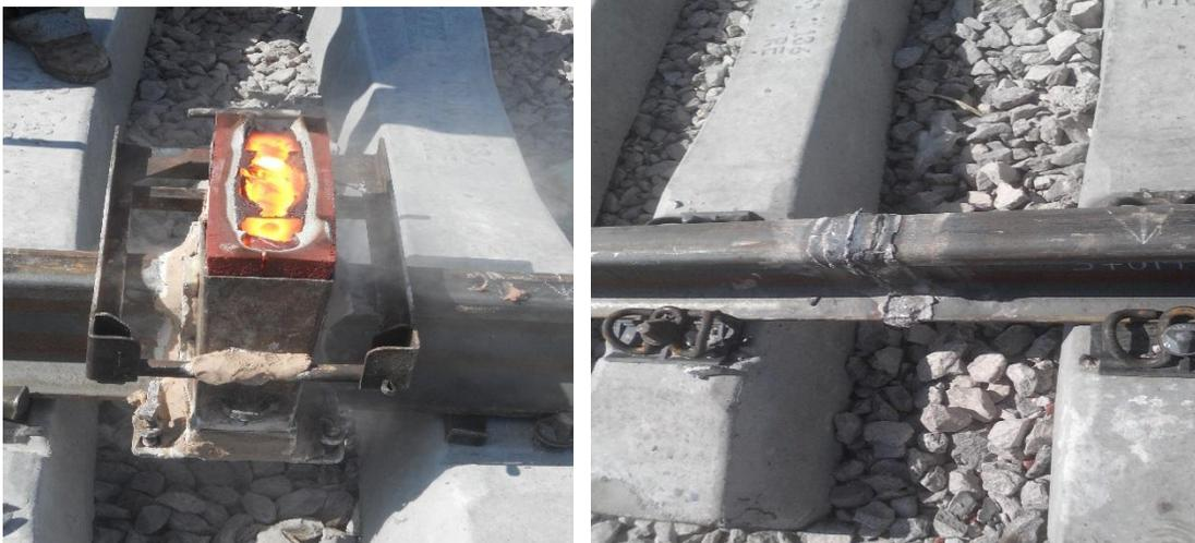
**Imagen 67,68:** Se muestra la soldadura del riel en el lugar, la cual puede efectuarse antes o después de su tendido, fuente: [libramiento ferroviario Celaya Guanajuato](#).
