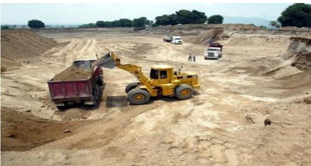
Imagen 56: En esta imagen se puede mostrar el trabajo que se realiza para los bancos de préstamo. Fuente:
