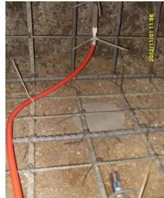
Después de la instalación de los dispositivos se procedió a tomar las lecturas iniciales y terminar el armado de la cimentación
