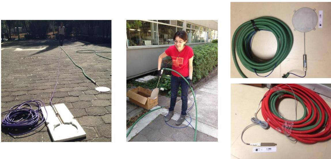
Figura 31. Colocación de ducto de protección a los cables de los instrumentos
