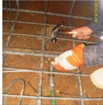
Para fijar la celda de presión al suelo, se fijaron sus cuatro vértices ("orejas") con clavos, también se emplearon dos varillas de acero en forma de grapa para asegurar el vástago.
