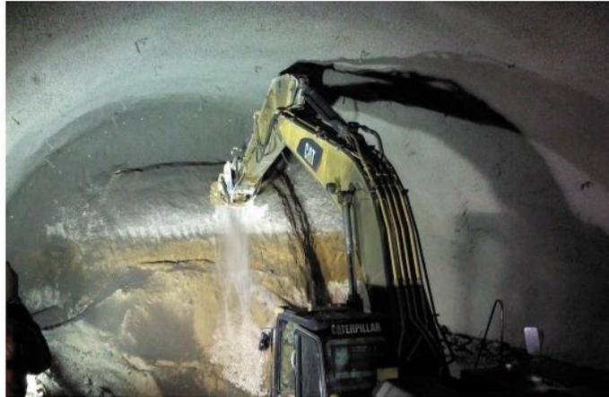
Frente de la media sección, lista para iniciar de nuevo la excavación de la sección 1 o túneles piloto.
