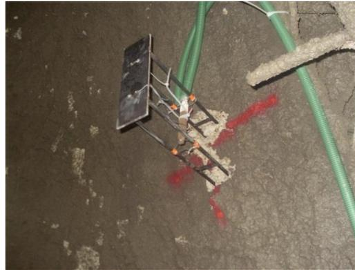
Registro de lecturas de deformación iniciales previo al lanzamiento del concreto.
