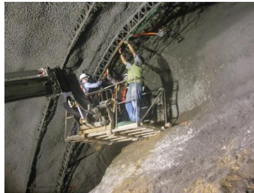
Deformímetros SGV-4A, SGV-4B y SGV-4C (ver Figura 30) instalados en la clave del túnel.
