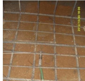
Instalación del deformímetro eléctrico SGV-8 en la zapata derecha, en posición vertical, sobre la línea de acción de la celda de presión como se indica en la Figura 30.
