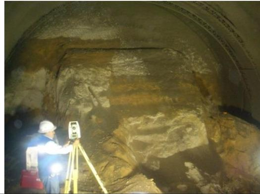
Instalación del soporte, con el deformímetro fijado, hincándolo 20 cm en el suelo (arenas pumíticas y tobas volcánicas). Se tuvo precaución en la correcta orientación del deformímetro para que midiera solamente la deformación tangencial.
