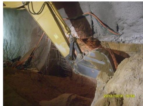
Instalación de la celda de presión CPVW-1 (ver Figura 30) para quedar en contacto entre el suelo y el concreto de la zapata izquierda.
