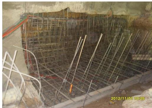
Lanzado de concreto de la zapata izquierda.
