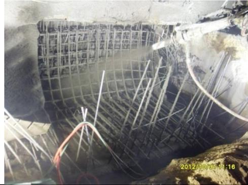
Registro de lecturas de deformación y presión de los instrumentos ya instalados durante el lanzamiento de concreto.
