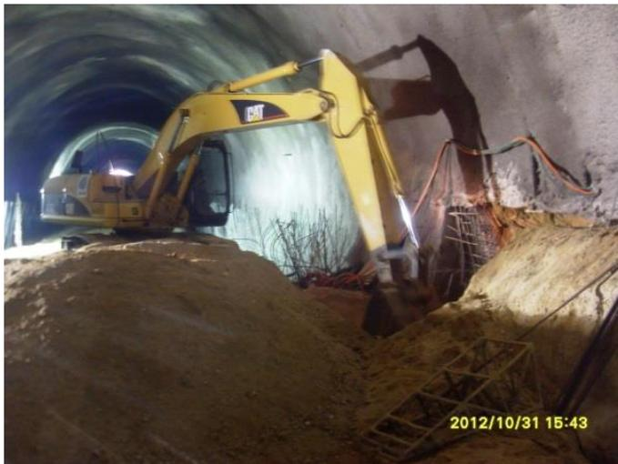
Armado de la zapata y lanzamiento de concreto.
