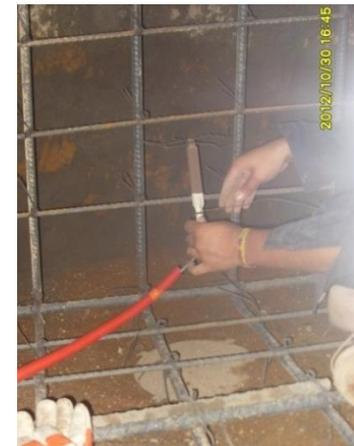
Posición final del deformímetro eléctrico y celda de presión de cuerda vibrante en el espacio correspondiente a la zapata derecha.
