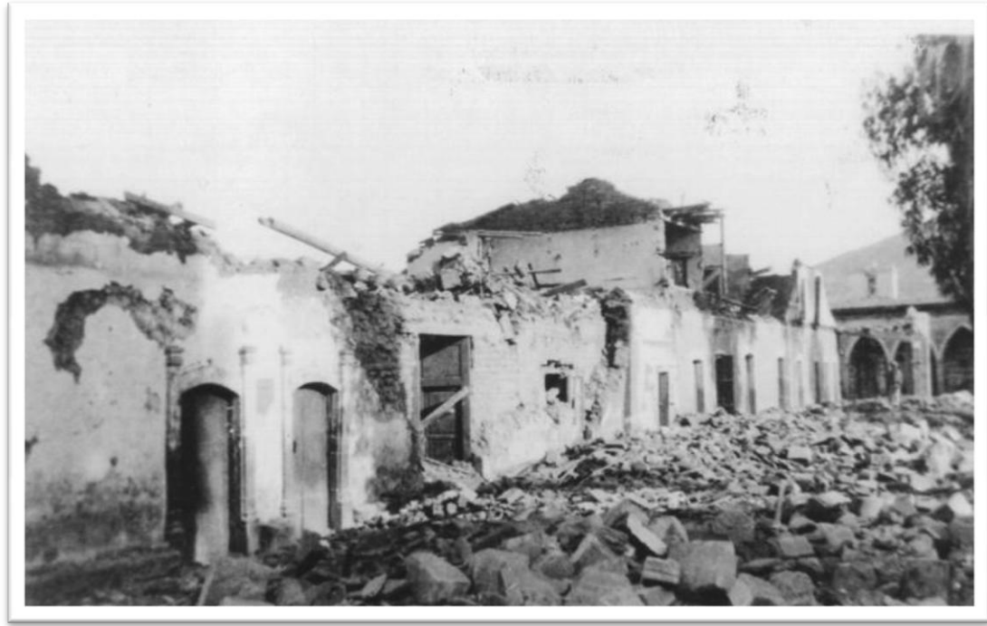
Fig. 1.3: Fotografía de las destrucciones en el pueblo de Acambay ocasionadas por el terremoto de 1912 (Urbina y Camacho, 1913).
