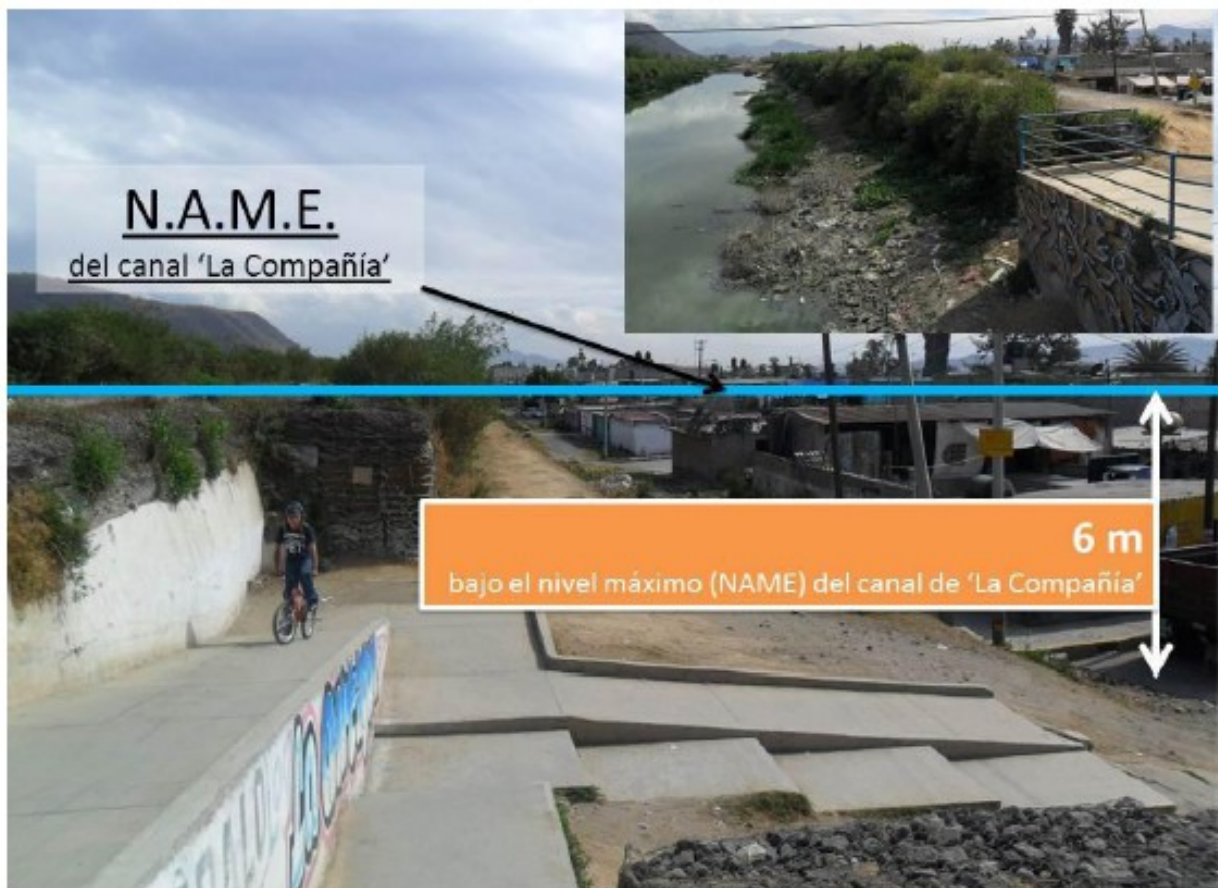
Figura 4.2 Efectos por hundimiento acelerado en colonias de Valle de Chalco
