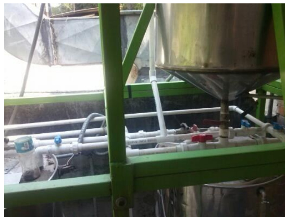
Figura 3.8 Instalación de tubería y llaves de paso de PVC
