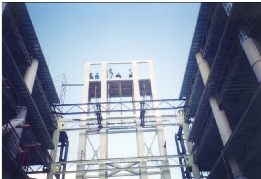
Imagen 14. Cubo de Elevadores. Estructura independiente al edificio.
