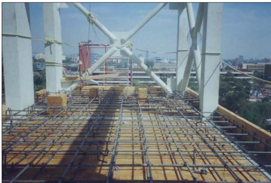
Imagen 15. Armado de losa en Cuarto de Máquinas.
