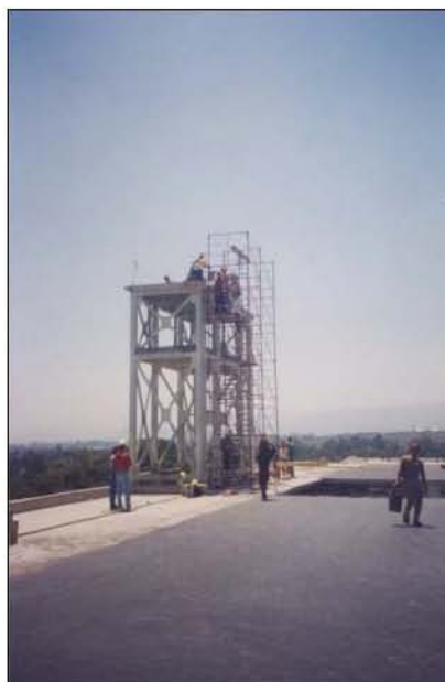
Imagen 16. Colado de losa en Azotea.
