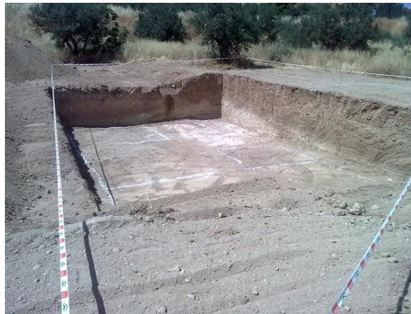
Fig. 74 Ejemplo de excavación para casa bioclimática
