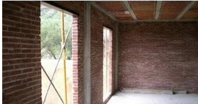
Fig. 78 Muros internos de vivienda bioclimática
