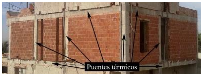
Fig. 81 Puentes térmicos
