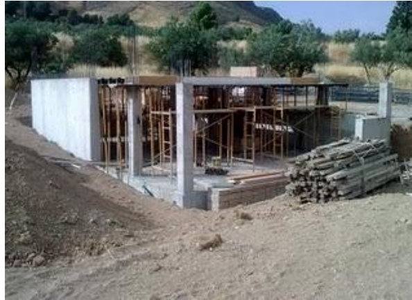
Fig. 75 Construcción de semisótano
