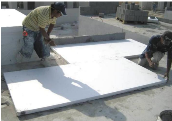
Fig. 49 Aplicación de placas de poliestireno
