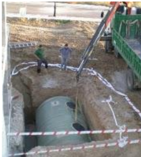
Fig. 73 Colocación de depósito de reutilización en casa bioclimática
