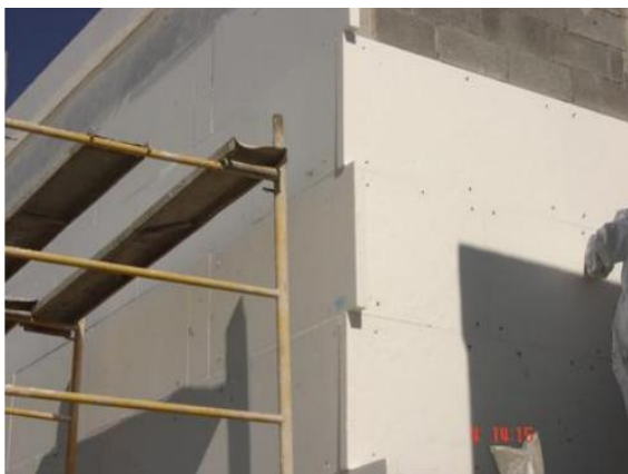
Fig. 50 Aplicación de placa de poliestireno en muros
