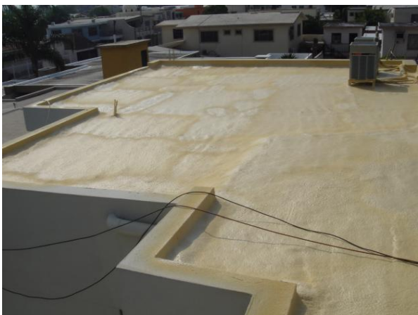
Fig. 53 Azotea con aislante de poliuretano
