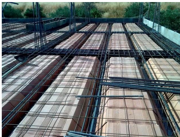
Fig. 76 Ejemplificación de sistema vigueta bovedilla
