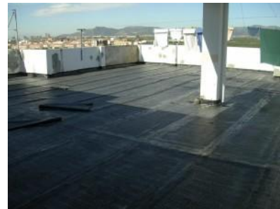
Fig. 19 Impermeabilización asfáltica
