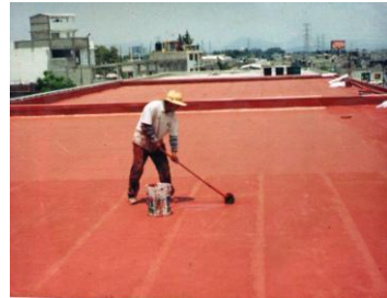
Fig. 20 Impermeabilización acrílica
