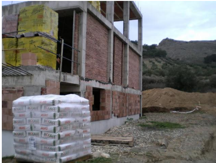
Fig. 79 Colocación de block de termoarcilla
