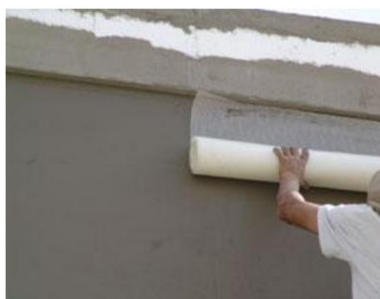
Fig. 51 Colocación de malla reforzada
