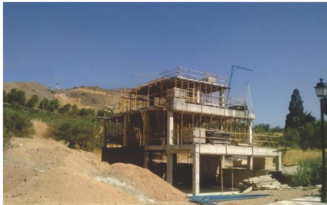
Fig. 77 Ejemplificación de estructura finalizada
