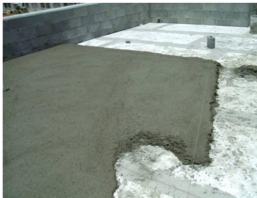
Fig. 48 Aplicación de firme de concreto y arlita
