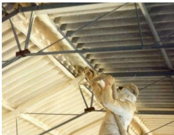
Fig. 52 Colocación de poliuretano esreado
