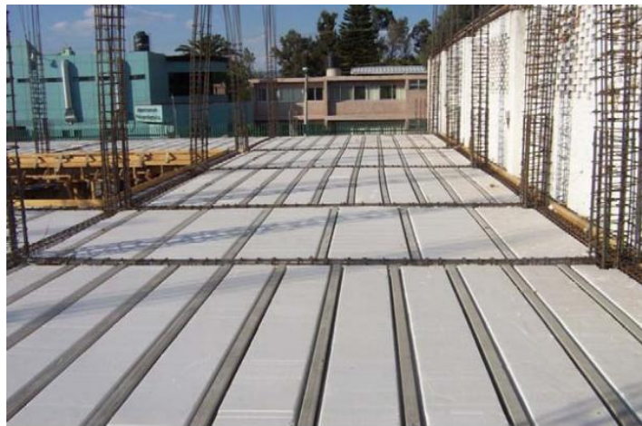
Fig. 56 Aplicación de vigueta y bovedilla
