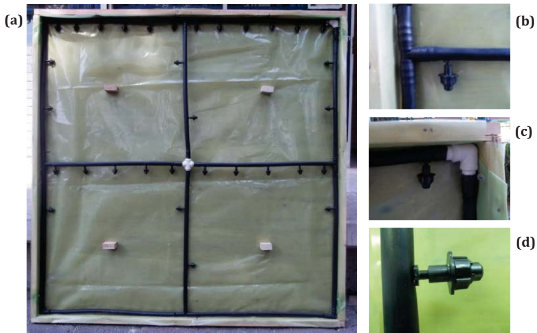
Figura 22. (a) Vista anterior de uno de los paneles verticales, en donde se aprecia el sistema de riego conectado en circuito cerrado. (b y c) Conexiones del sistema tipo "T" y "C". (d) Acercamiento de uno de los nebulizadores del sistema.
