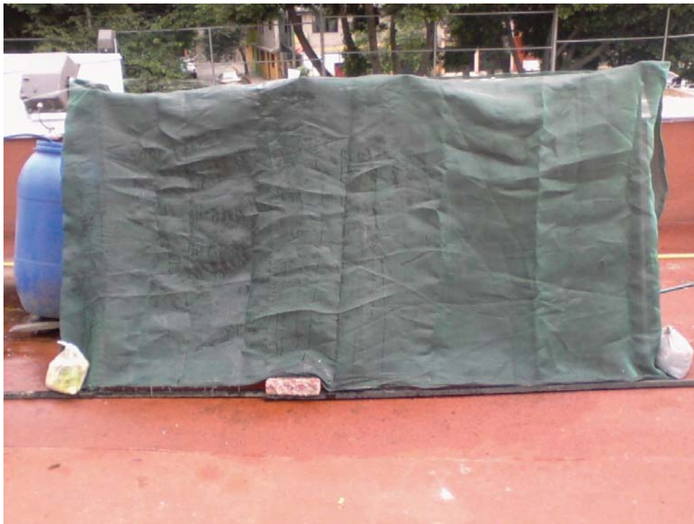
Figura 32. Colocación de la malla sombra a ambos paneles.
