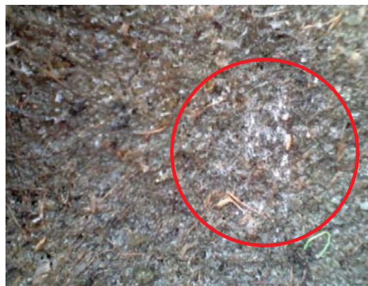
Figura 40. Presencia de moho (círculo) sobre la hidrosiembra en el tercer día después del hidrosembado.
