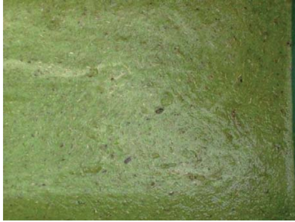
Figura 28. Apariencia física de la hidrosiembra experimental terminada.
