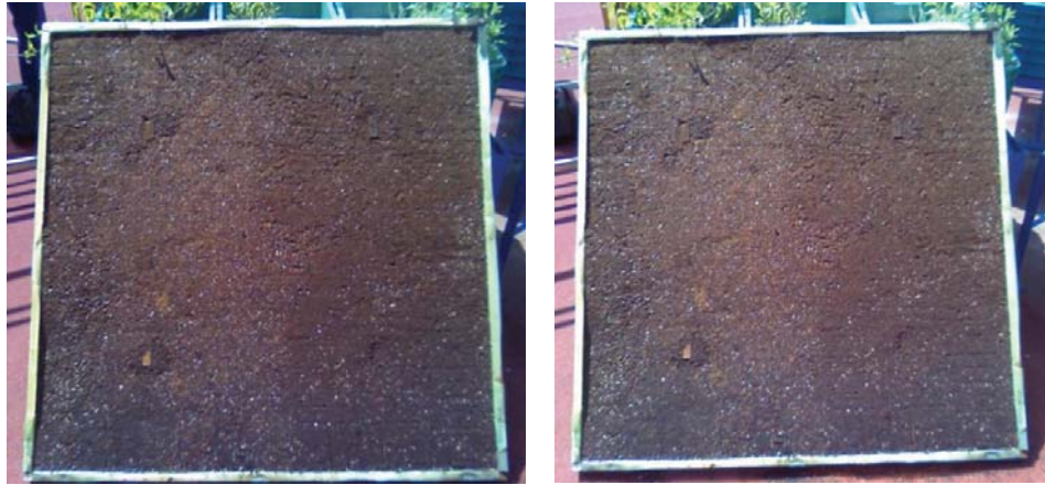
Figura 26. Páneles verticales sólo con el sustrato montado y compactado.
