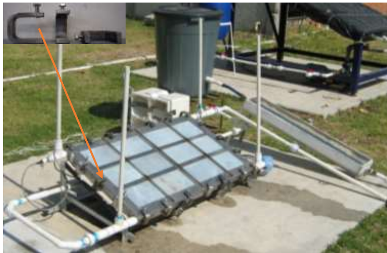
Figura 38. Pruebas hidrostáticas en el reactor RF03 en la Planta Solar.
