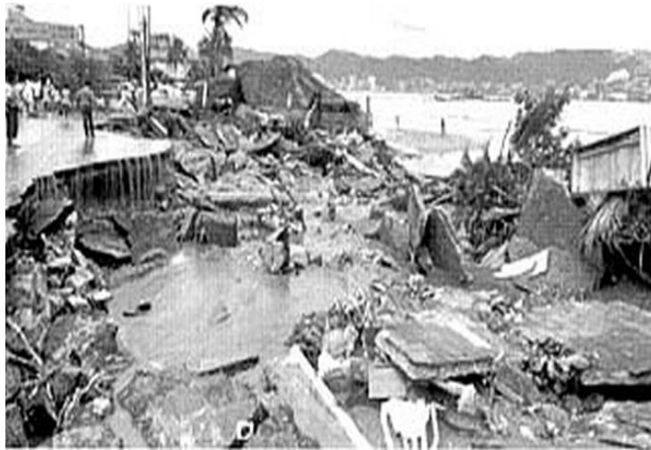
Figura 18. Daños costeros del Huracán Paulina (Gutiérrez y García, 1997). Se observa el potencial erosivo y los daños a la infraestructura turística debido al oleaje intenso.
