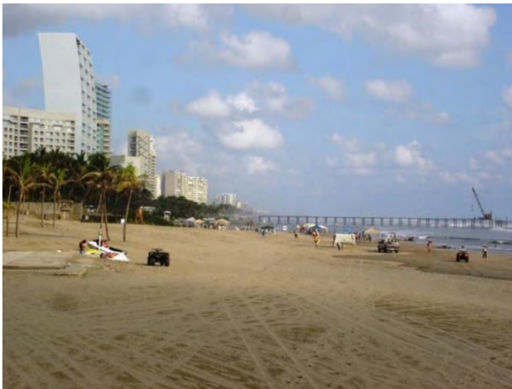
Figura 35. Construcción de muelle privado aledaño a la estación de medición 2. Fotografía tomada el 16/09/2012 con dirección SE. Al momento de la captura de la imagen la construcción del muelle estaba en proceso, junto con la presencia de maquinaria pesada.
