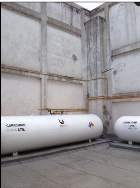
Trayectoria de las líneas de conducción
