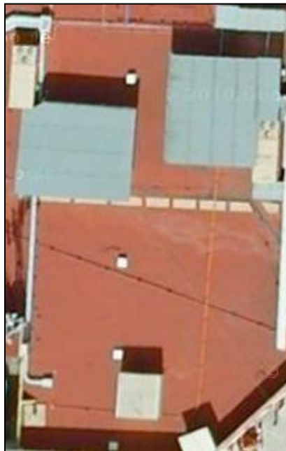
Figura 4.1 Vista superior del espacio propuesto para la instalación del sistema de bioenergía
