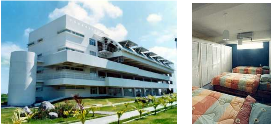
FIGURA 31. Fachada del edificio y habitaciones
