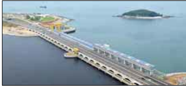
Figura 5.65 Central eléctrica en Corea del Sur
