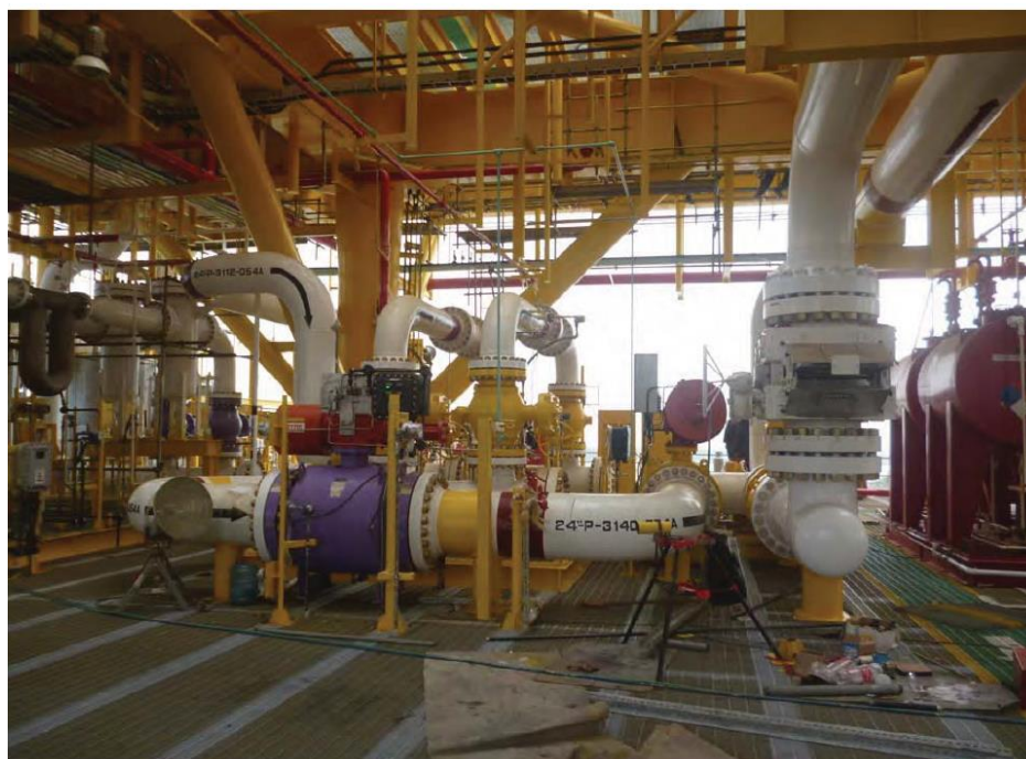
Fig. 6.6 a. Sistema de medición instalado
