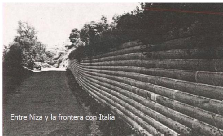
Fig. 5.2 Primer Muro de Tierra Armada 1964
