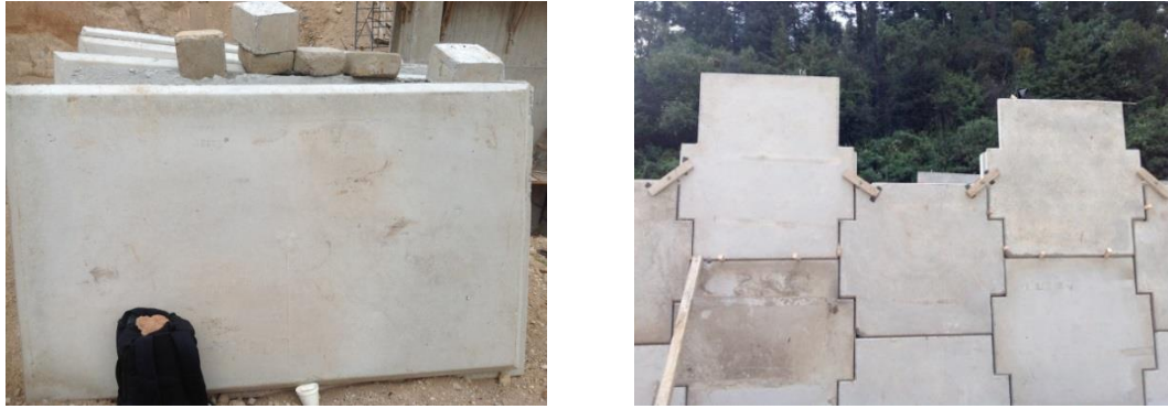
Fig. 5.16 Paneles de Concreto
