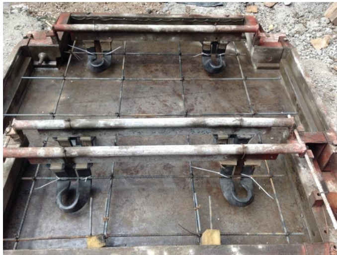
Fig.5.17 Acero de refuerzo por temperatura en el panel de concreto
