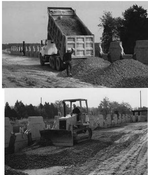
Fig. 5.26 Descarga y extendido de material de relleno
