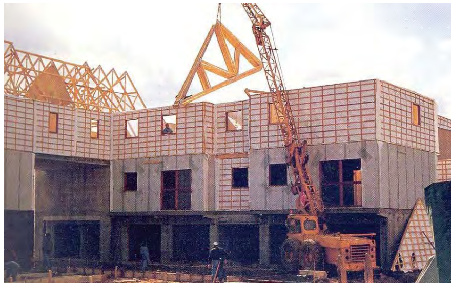
Figura 5.1B – EMPLEO DE CIMBRAS METÁLICAS (1) Y DE PANELES ALIGERADOS DE POLIESTIRENO EXPANDIDO CON BASTIDORES DE MADERA (2).
