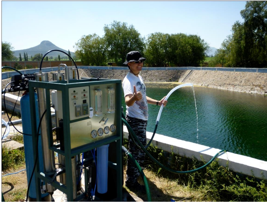
Figura 6. Instalación exitosa de la planta piloto, primer flujo de permeado.
