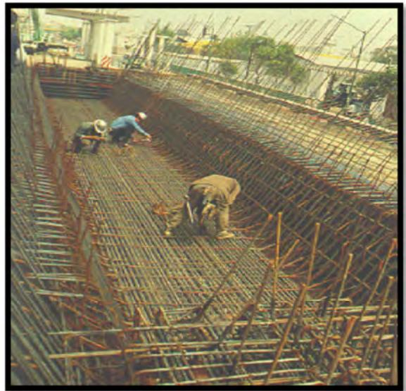
Figura 56. Fabricación en obra de una viga cajón con aletas pretensada
