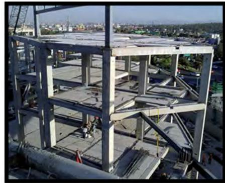
**Figura 42. Trabes, losas y columnas como elementos presforzados**
