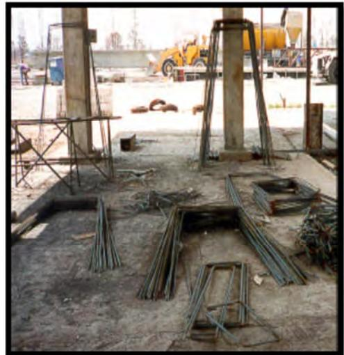
**Figura 64. Corte y modelado de varilla de acero**
