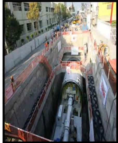
**Figura 48. Túnel del cajón para el metro Cd. México**
