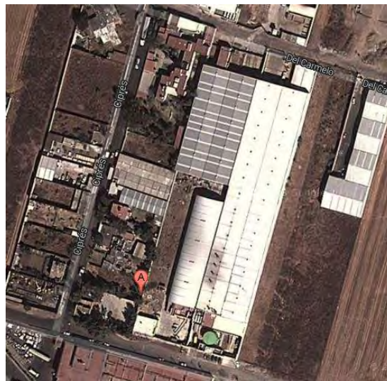
Figura 2. 4 Nave Industrial de Tejidos y Acabados, S.A. de C.V.
