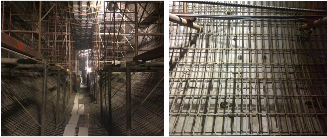
Imagen 3. 27 Armado de acero para el revestimiento definitivo
