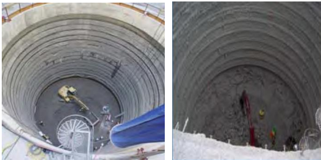
Imagen 3. 4 Construcción de lumbreira (Excavación Convencional)
