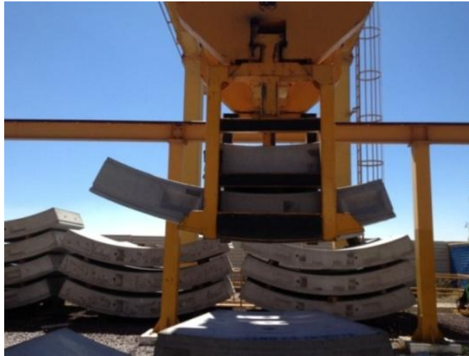
Imagen 3. 12 Grúa Pórtico en operación en el patio de planta de dovelas.
