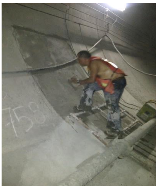
Imagen 3. 20 Personal reparando el revestimiento
