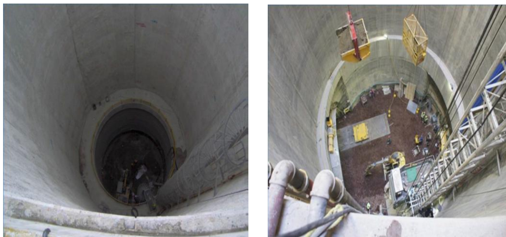
Imagen 3. 5 Construcción de lumbrera (Muro Milán y Excavación Convencional)
