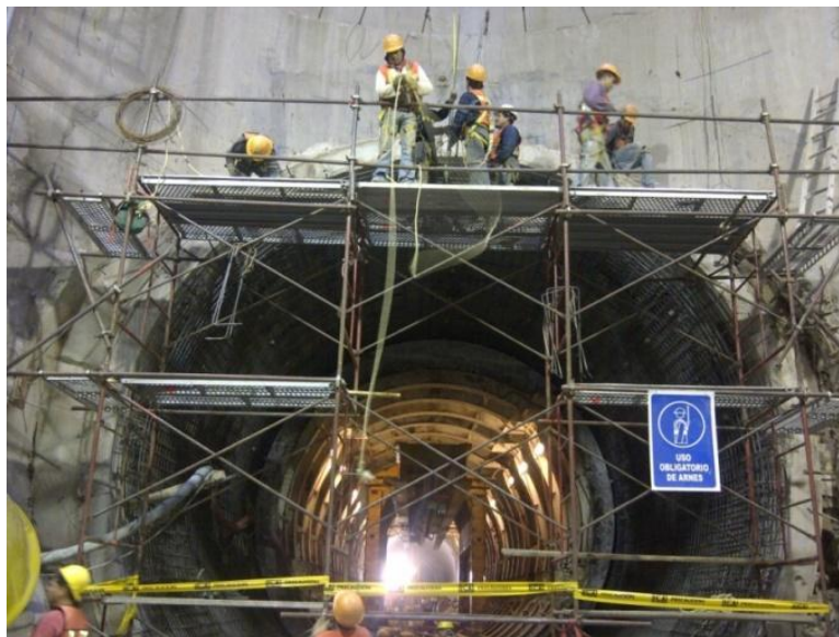
Imagen 4. 2 Señalamiento y cumplimiento por parte de los trabajadores
