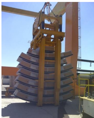
Imagen 3. 14 Grúa Pórtico, con las piezas correspondientes a un anillo
