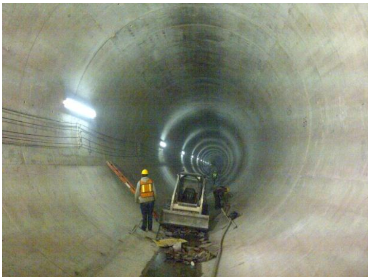
Imagen 4. 4 Acabado final con un diámetro de 7 metros
