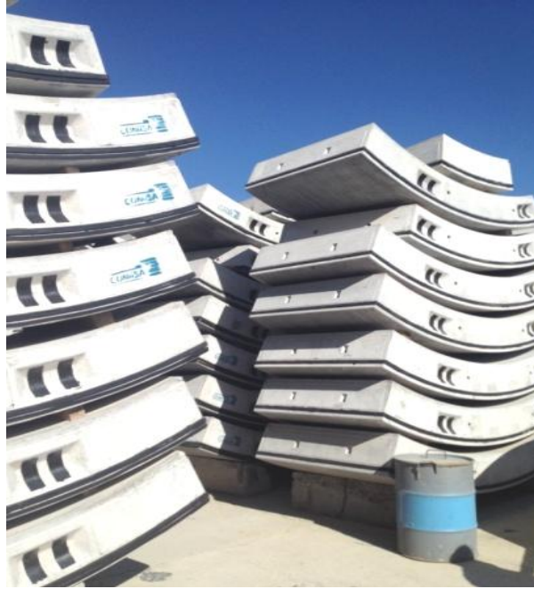
Imagen 3. 22 Dovelas colocadas en el sitio de almacenamiento
