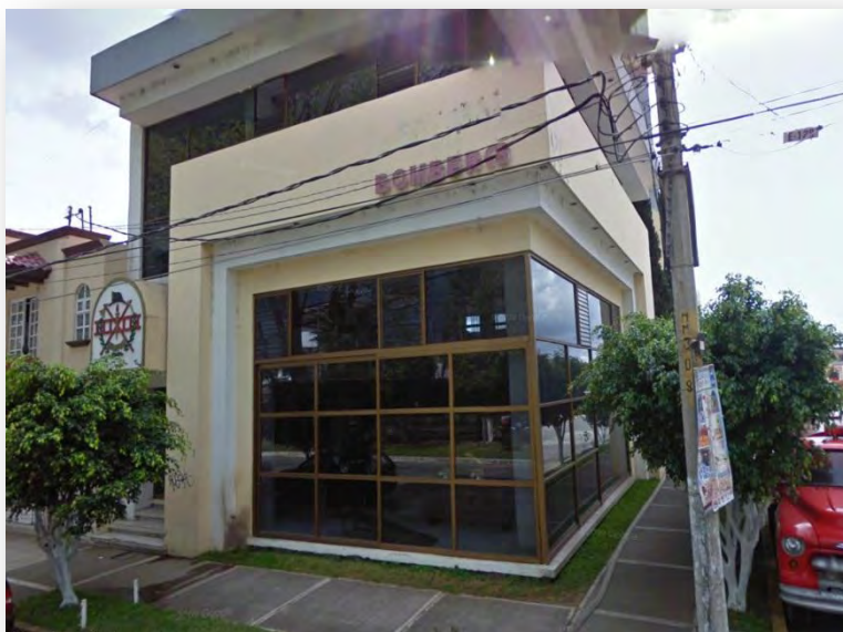
Fachada Av. Latinoamericana
