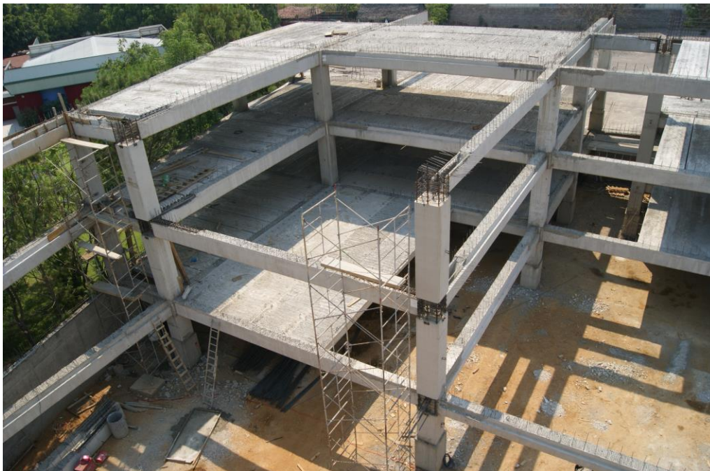
Figura 3.14 Estructura de marcos prefabricados, cortesía de Technoo Sustentable en Oaxaca S.A. de C.V.
