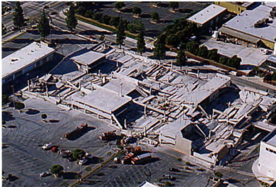
Figura 1.12 Colapso de sistema de piso prefabricado sismo de Northrige 1994
