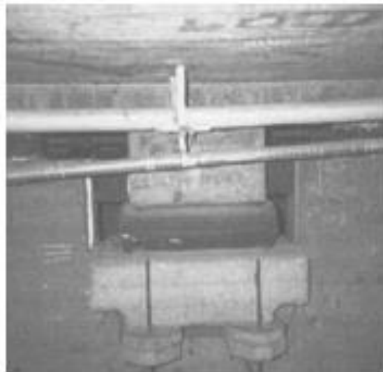
Figura 1.9 Aislador elastomérico sin refuerzo vertical Skopje Yugosl (Kelly, 1999)
