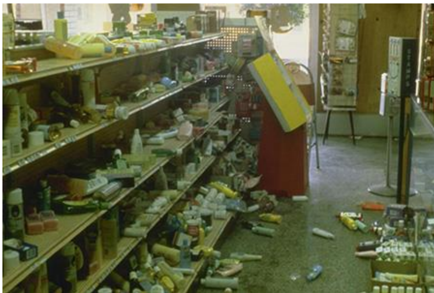
Figura 1.5 Falla inercial en contenidos de una farmacia (FEMA-E74 2013)
