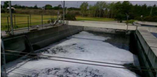
Fig 1 Tanque de homogenización
