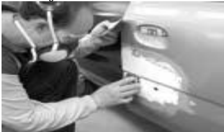
Figura 4.5 Proceso de enmasillado
