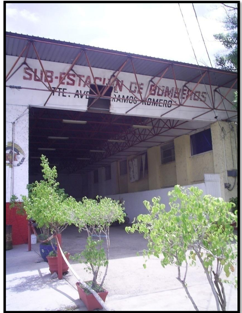
Fachada de la subestación de Cd. Renacimiento. Cuenta con una cubierta de 8 metros de altura.
