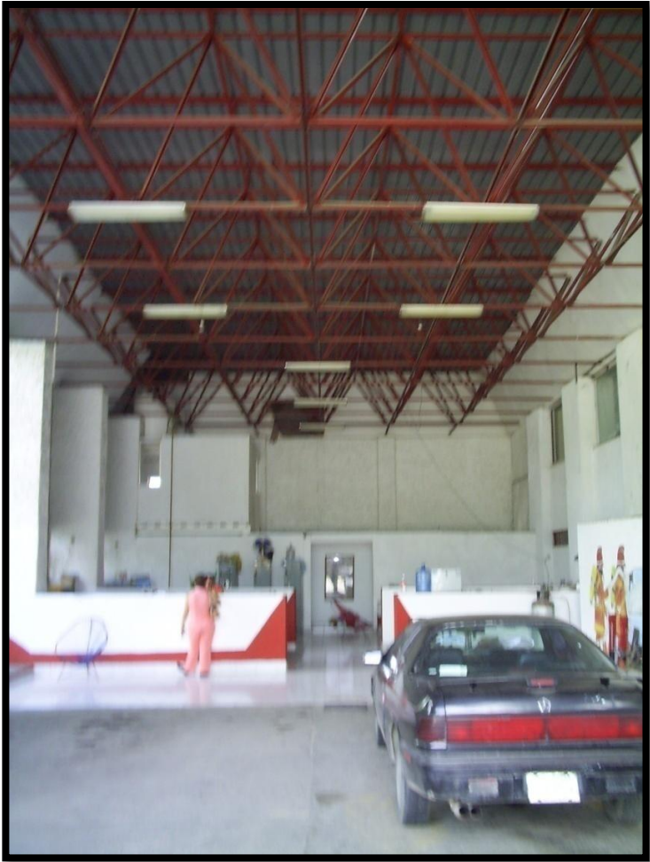
Interior de la subestación. Cuenta con 2 unidades: Un Coche bomba y una camioneta (ninguna de estas unidades funciona).
