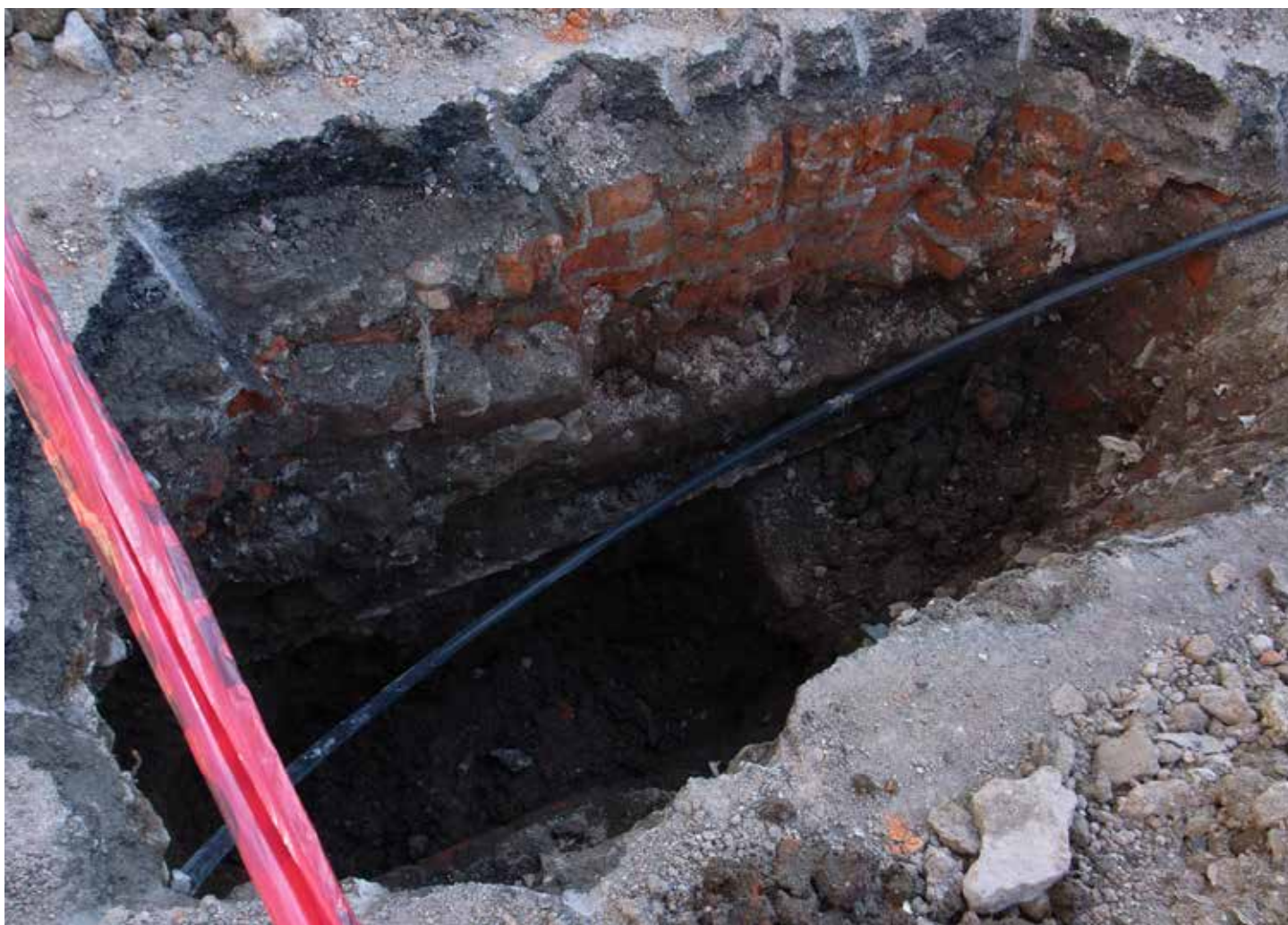
Excavación en Santa María la Ribera.
