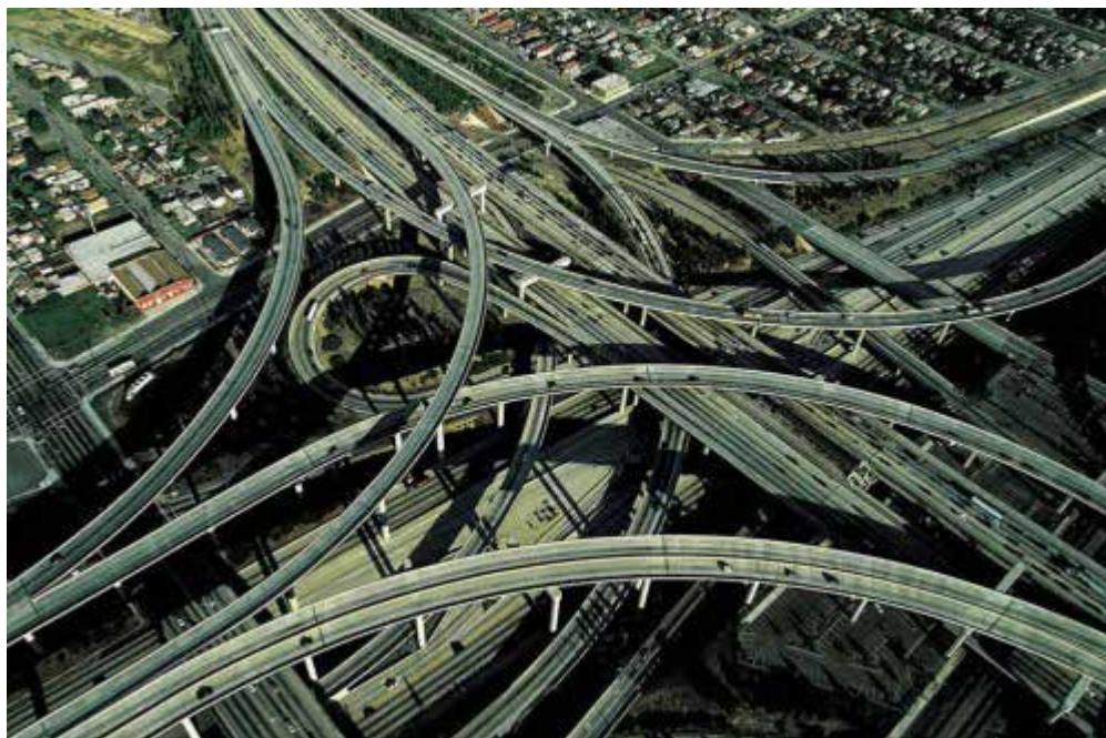
Vialidades elevadas o freeways en Los Ángeles California
