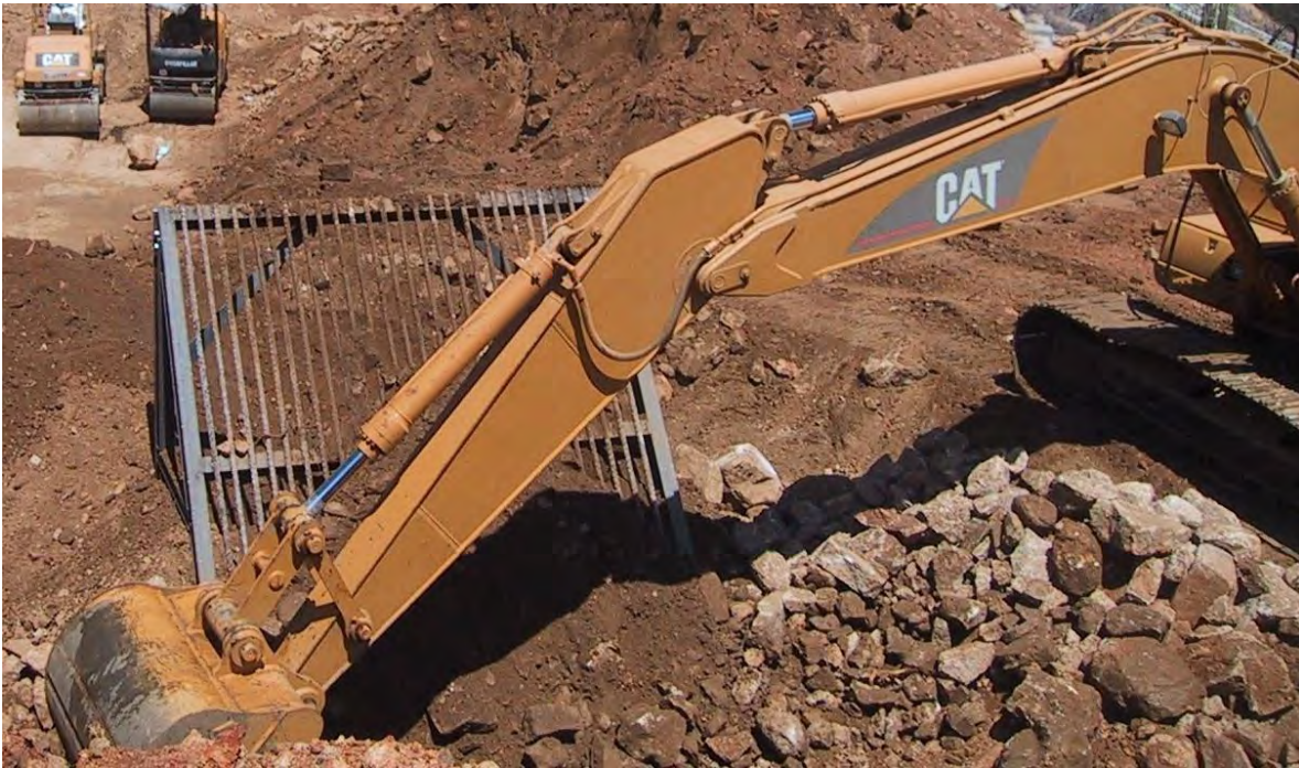
Foto 5.3 Cribado de material para piedra y material de relleno compactado.
