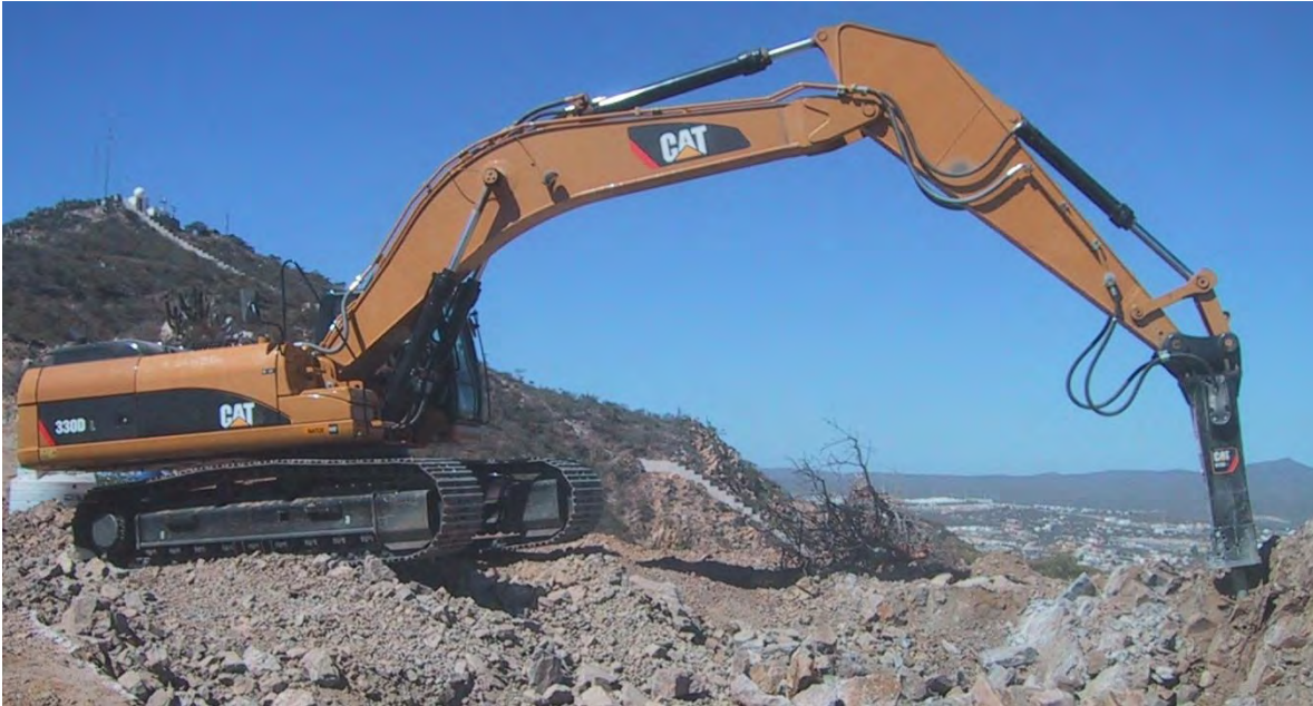
Foto 5.6 Corte en material tipo III.
