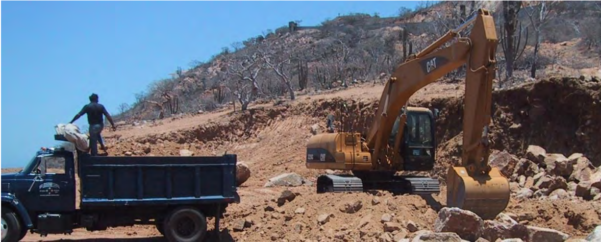
Foto 5.2 Corte y carga directa material tipo II.
