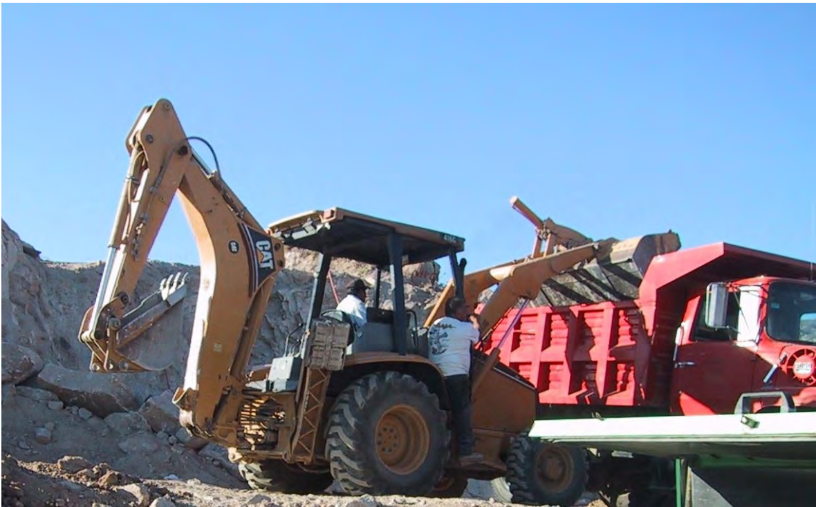
Foto 5.5 Carga de material tipo II.
