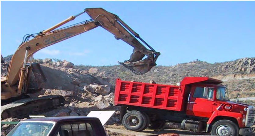
Foto 5.8 Carga y acarreo de piedra para muro.
