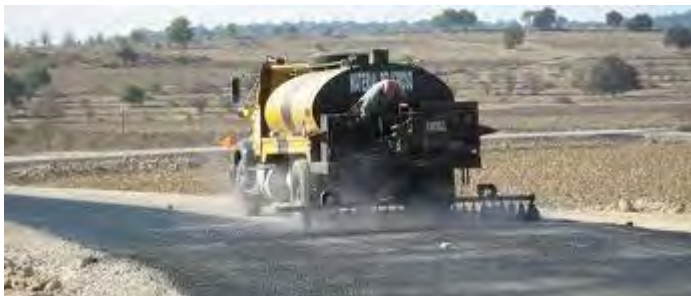
Foto 3.8.b.5 Riego de impregnación.
