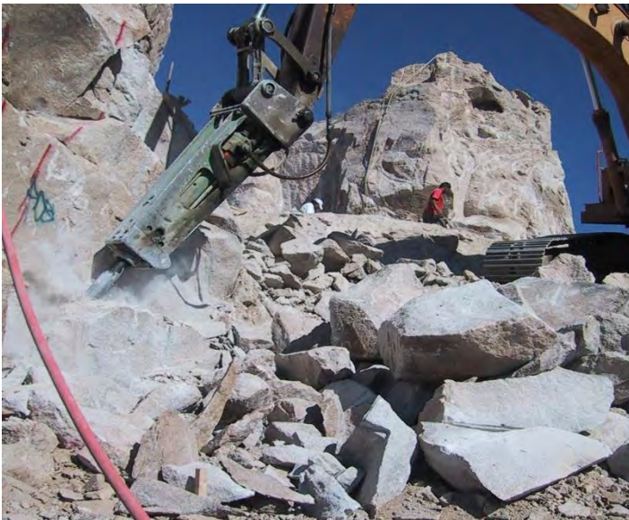
Foto 5.7 Hacer piedra a tamaño para muro y afine de talud.
