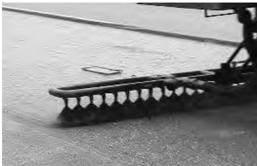
Foto 3.8.b.4 Riego de liga con emulsión asfáltica
