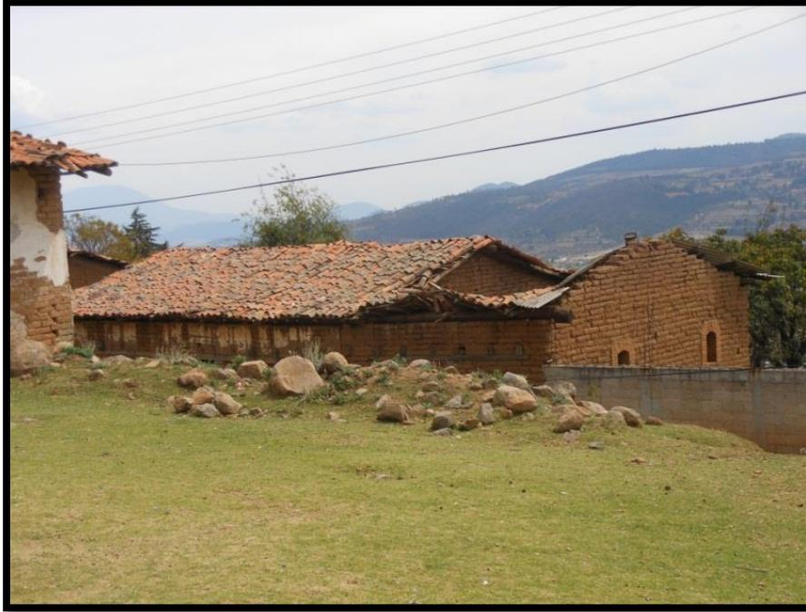
Figura 13. Daño al techo de una casa por caída de bloques la cual pudo originarse durante el sismo de 1912.
