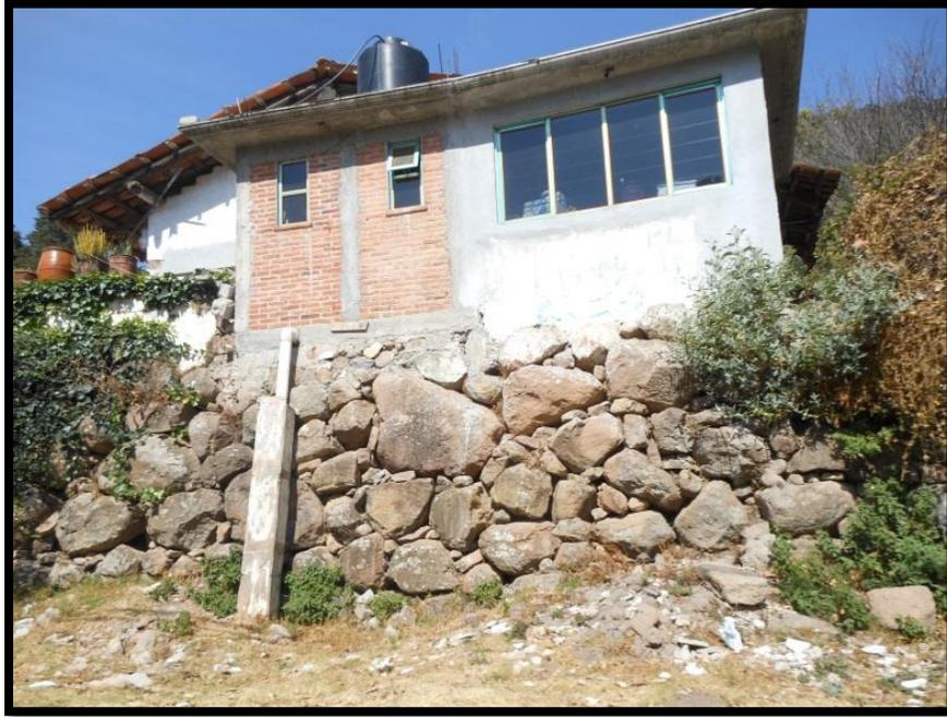
Figura 11. Base de bloques que son utilizados para nivelar la vivienda.
