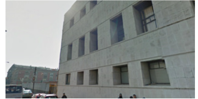
2. Las entrecalles se conservan en la fachada trasera del Teatro sobre la calle de Santa Veracruz
