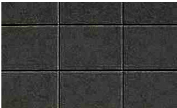
Placas de cantera negra para los muros inclinados
