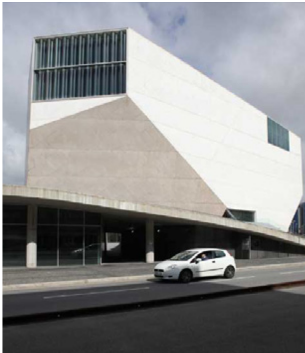
Volumen exterior fachada posterior
