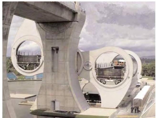
Figura 1.4 (b) Engranajes planetarios para transmisión de grandes potencias en un puente rotativo [17].
